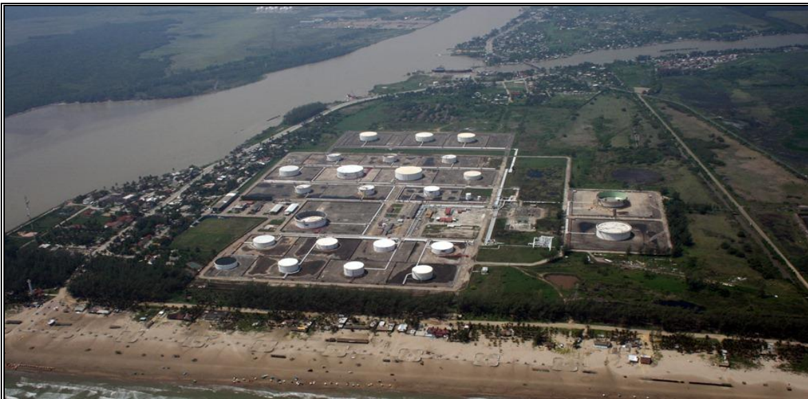
Fotografía VI-1 Instalaciones de PEMEX en la Isla de los Potreros, Tuxpan
