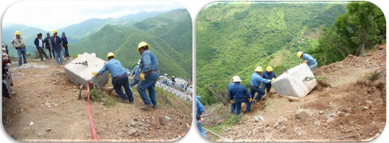
Figura 107. Maniobras para la instalación de pesos muertos como puntos de anclaje
