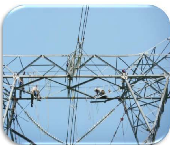
Figura 93. Anclaje de conductores de la fase central a la ventana de la estructura
