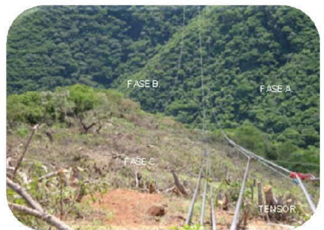
Figura 100. Recuperación de conductores de las fases A y B.
