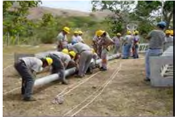
b) Asegure la conexión hembra macho, utilice las marcas para su correcto ensamble.
