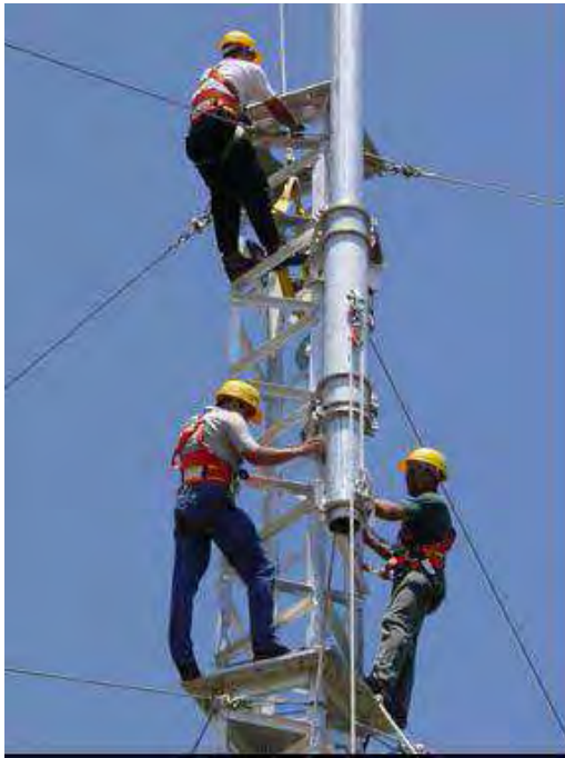
Figura 66. Colocación y aseguramiento del deslizador, para subir la pluma.
