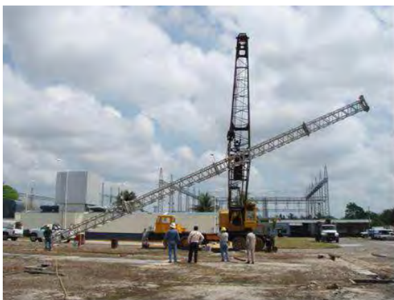
Figura 47. Izaje de columna por el método pivoteada con grúa, centro de gravedad.
