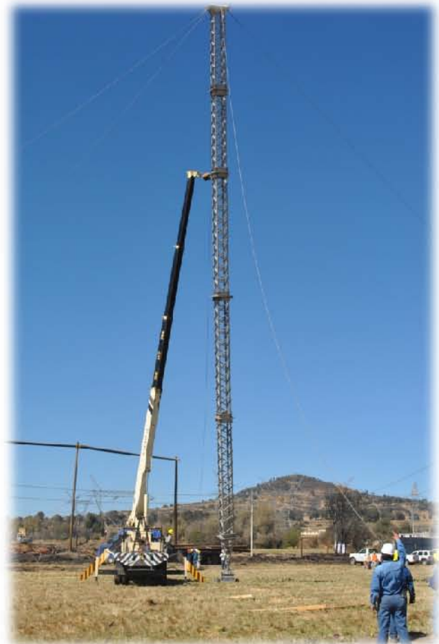
Figura 134 Izaje de la estructura con una grúa Telelect
