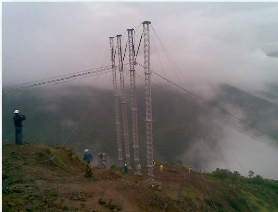
Figura 117. Arreglo final de la estructura de cuatro columnas
