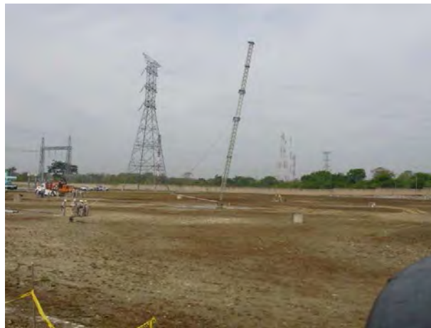
Figura 54. Columna pivoteada sobre su base con pluma en la base articulada
