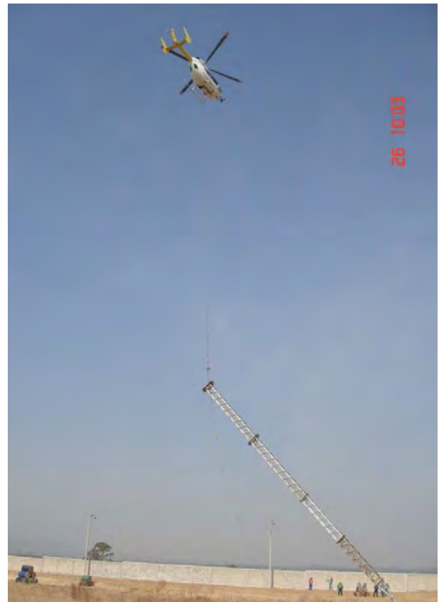
Figura 49. Columna pivoteada sobre su base con helicóptero.
