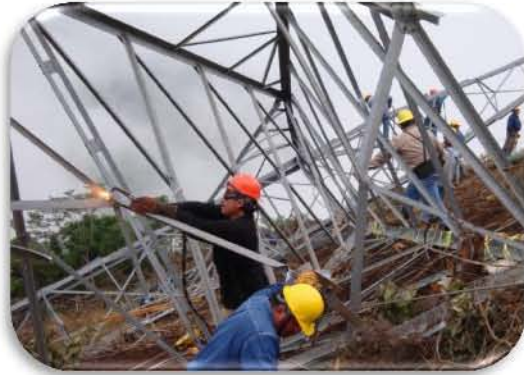
Figura 98. Desmantelamiento parcial de la estructura colapsada para la liberación de conductores
