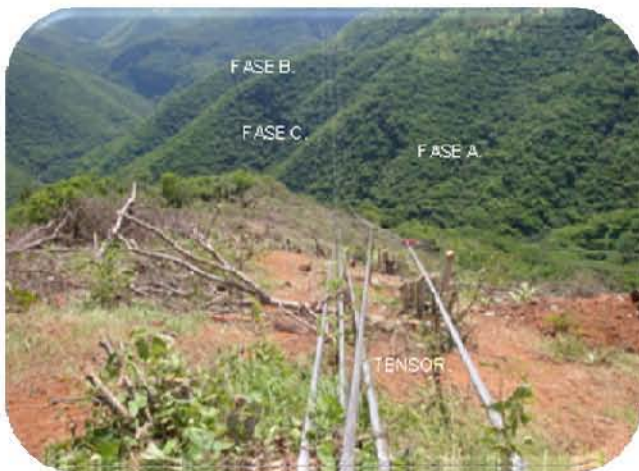
Figura 100. Recuperación de conductores de las fases A y B.
