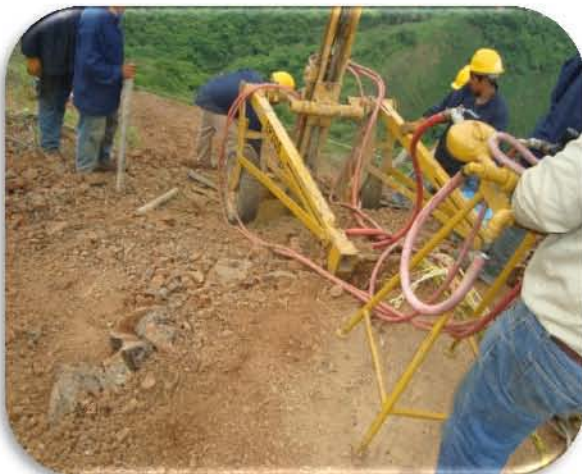
Figura 106. Perforación de barreno para anclas tipo mantarraya
