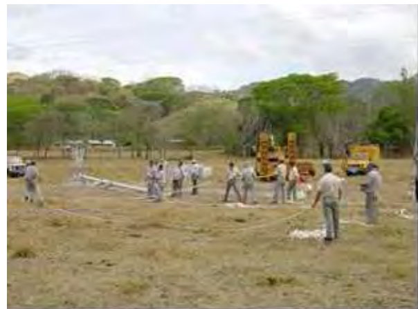
Figura 62. Ubicación de retenidas para izaje de pluma deslizante
