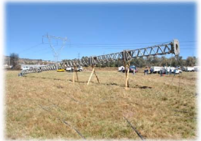
Figura 132. Armado de las columnas en piso.
