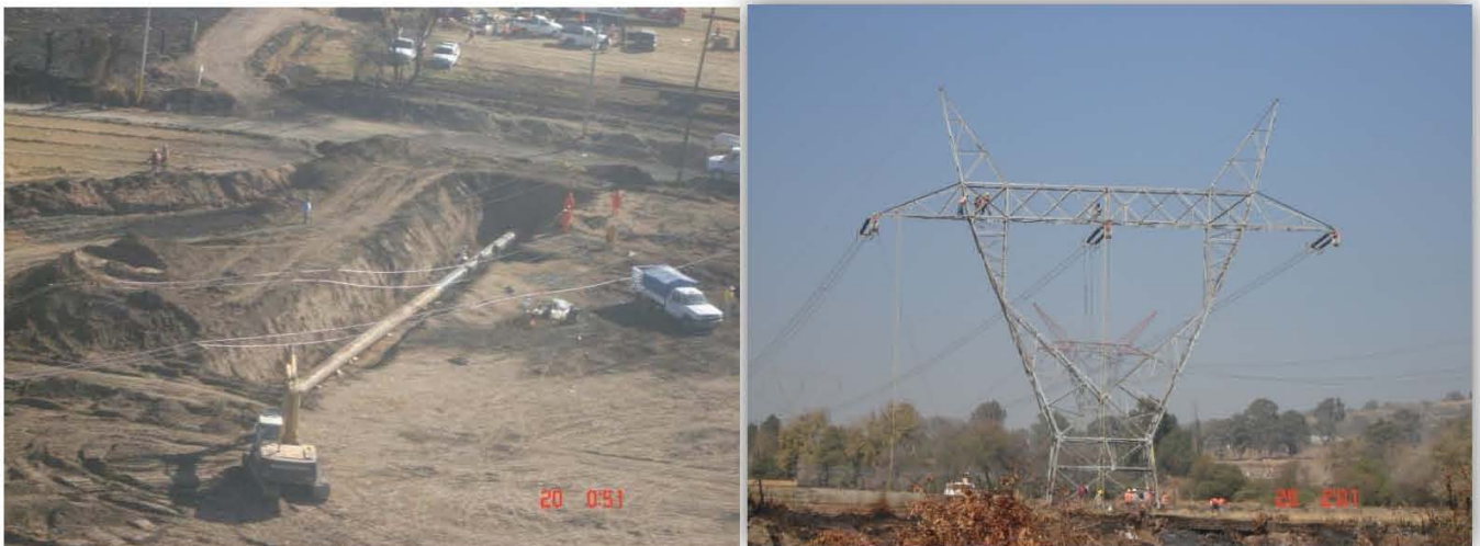
Figura 136. Maniobras para el tensionado de conductores en T-65
