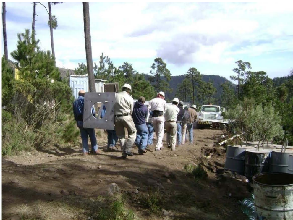
Figura 86. Restablecimiento de estructuras colapsadas en la L.T. TOP-A3510-BRN
