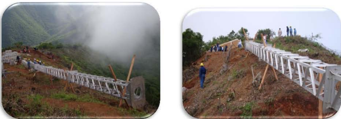
Figura 110. Armado de la primer columna en piso.
