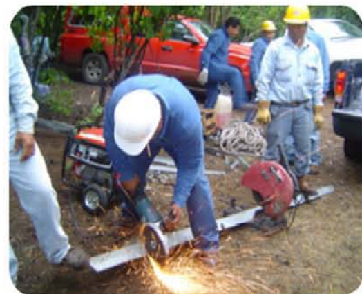
Figura 94. Secuencia de reparación de las traveses de las estructuras No. 494 y 495, se observa que el habilitado de algunos elementos se tuvo que realizar en campo.
