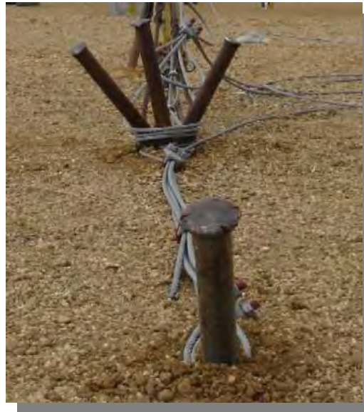
Figura 38. Uso de puntillas para retenidas temporales
