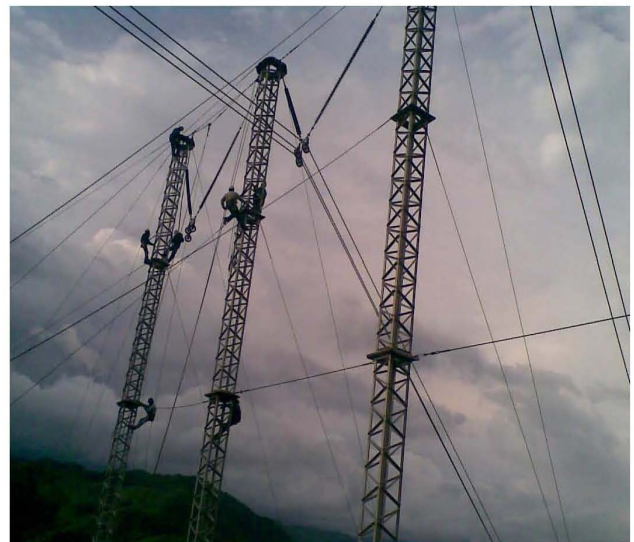
Figura XX. Maniobra para la subida de conductores a la estructura de emergencia
