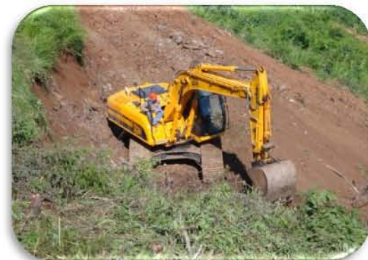
Figura 97. Habilitación de camino de un acceso
