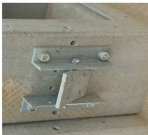
Figura 6. Accesorio adaptador para aislador tipo poste (cantiliever)
