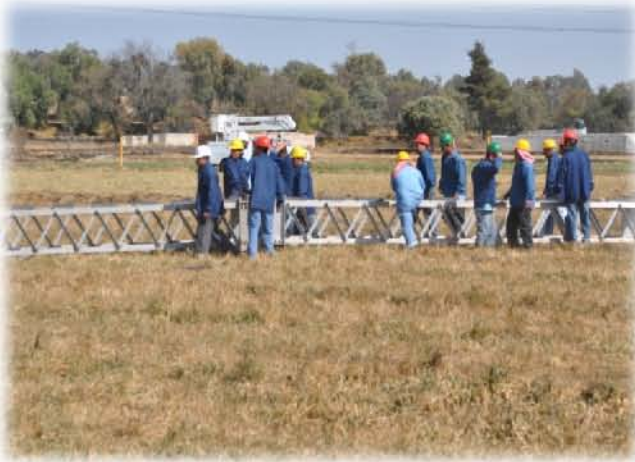
Figura 132. Armado de las columnas en piso.
