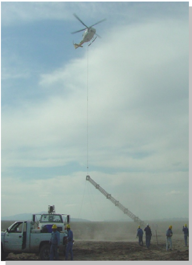
Figura 49. Columna pivoteada sobre su base con helicóptero.
