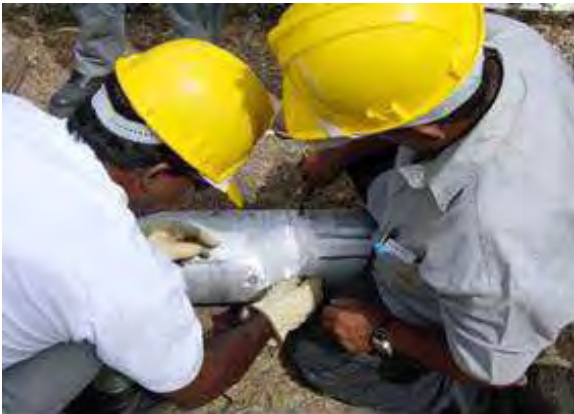
c) Asegúrela usando 4 tornillos Allen
