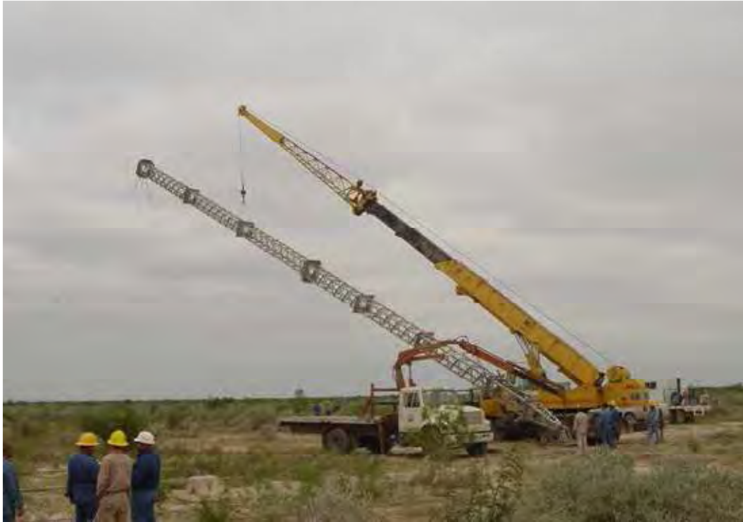
Figura 46. Columna pivoteada sobre su base con grúa.
