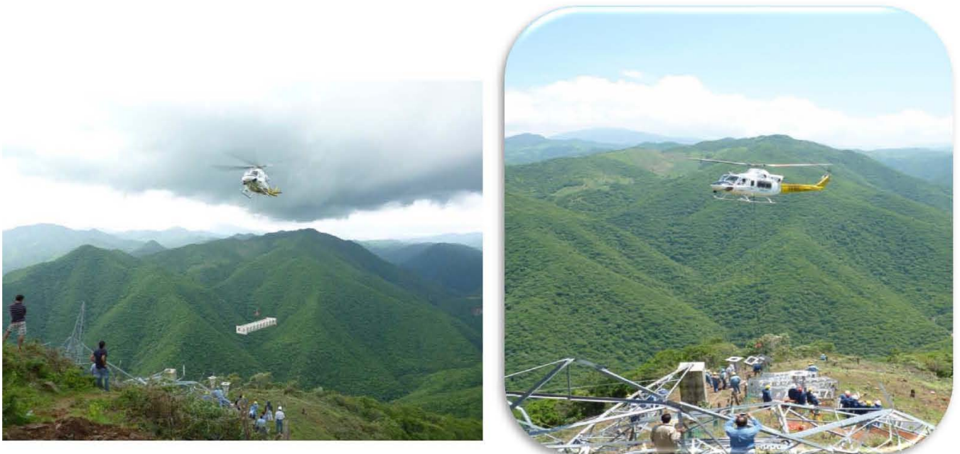
Figura 108. Maniobras de traslado de materiales con helicóptero
