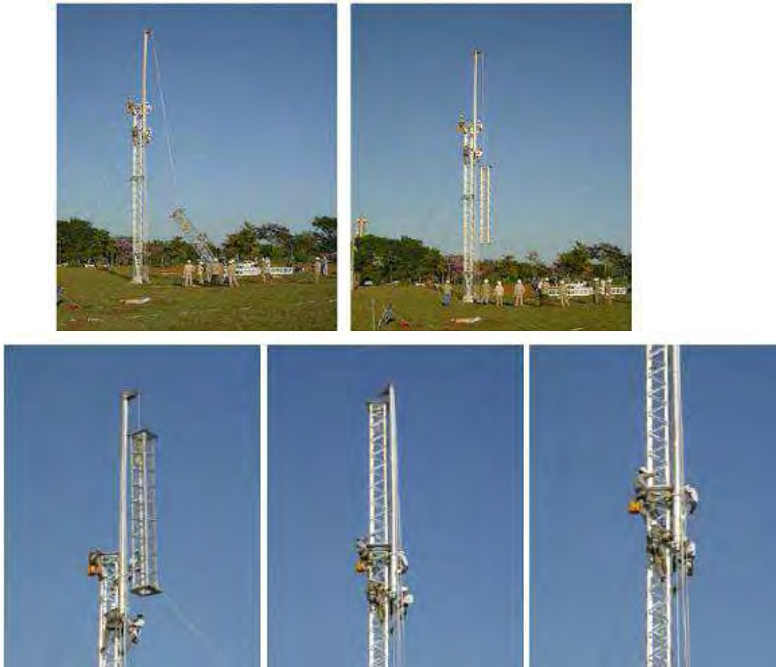
Figura 67. Colocación de la pluma deslizando para el armado de módulos
