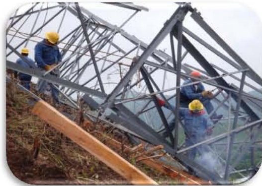
Figura 98. Desmantelamiento parcial de la estructura colapsada para la liberación de conductores
