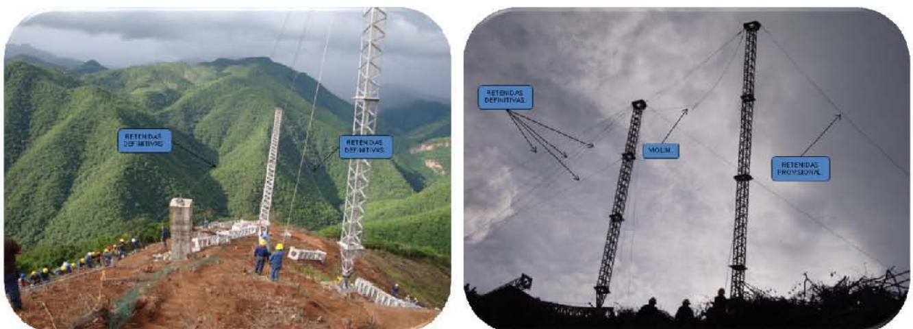
Figura 114. Izaje de la segunda columna de la estructura de emergencia
