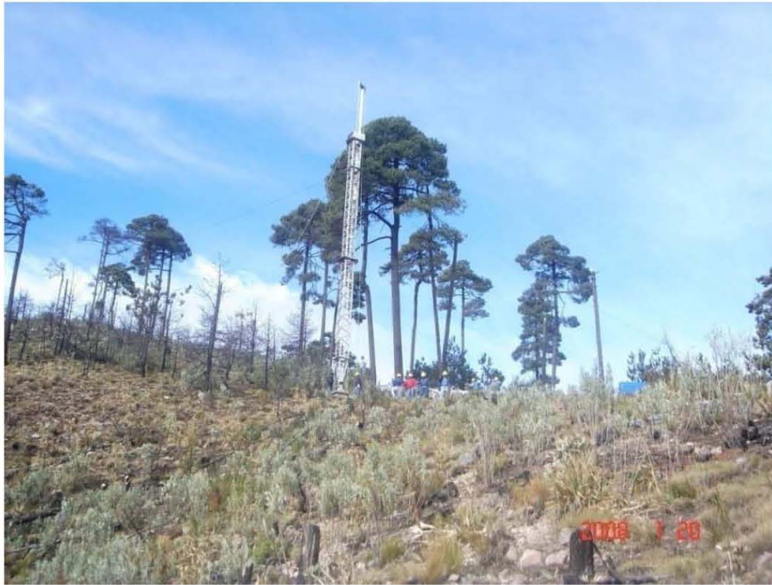
Figura 80. Armado de la T-50 con la pluma deslizante
