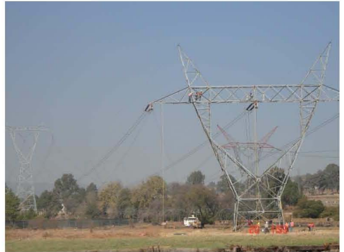
Figura 127. Instalación de retenidas en T-65
