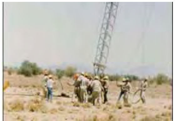
Figura 51. Armada en otro sitio, pivoteada y transportada con helicóptero al punto de uso.
