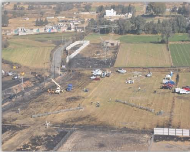
Figura 133. A la izquierda se observan las columnas armadas en piso, en tanto que a la derecha se observa la maniobra realizada con grúa.
