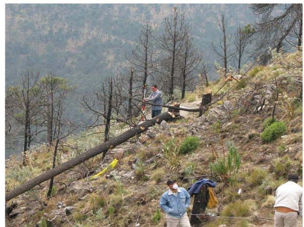
Figura 83. Obtención de perfiles longitudinales y contraperfiles del claro de estructura 49-50.
