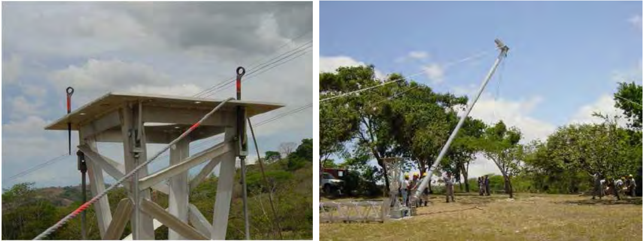
Figura 63. Izaje de la pluma deslizante
