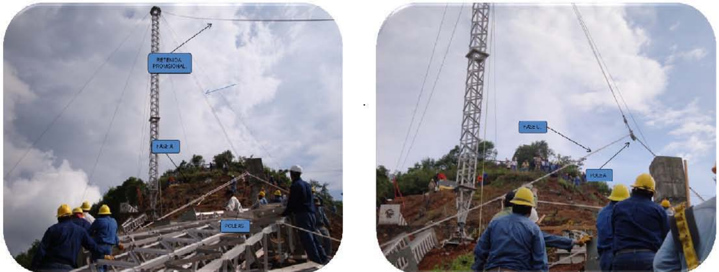
Figura 113. Recuperación de conductores de las fases A y C para alinearlos
