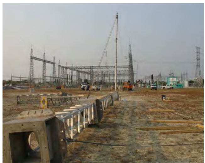
Figura 53. Maniobra para izar columna con pluma en la base
