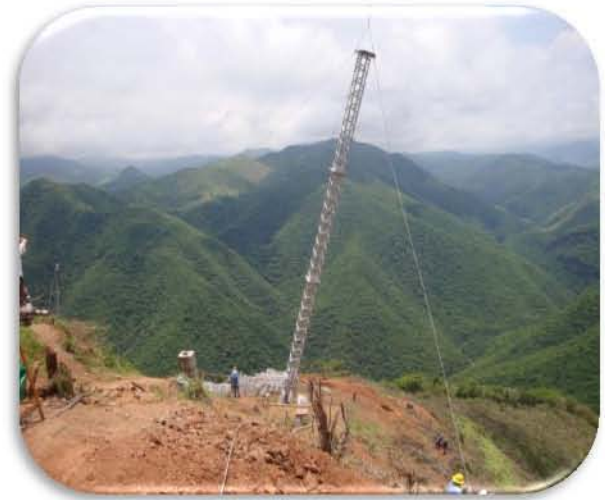
Figura 111. Izaje de la primera columna de la estructura de emergencia con apoyo del helicóptero.
