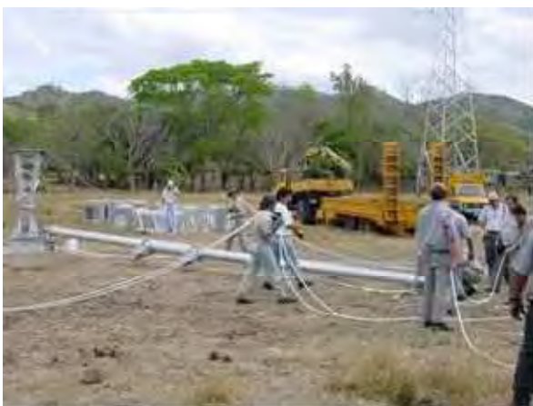
Figura 62. Ubicación de retenidas para izaje de pluma deslizante
