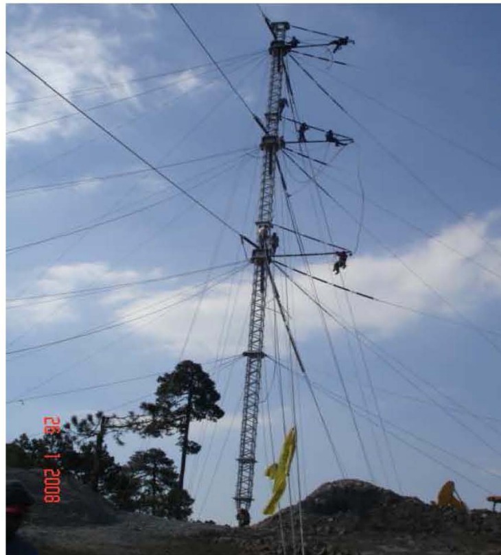
Figura 75. Trabajos realizados en la T-45
