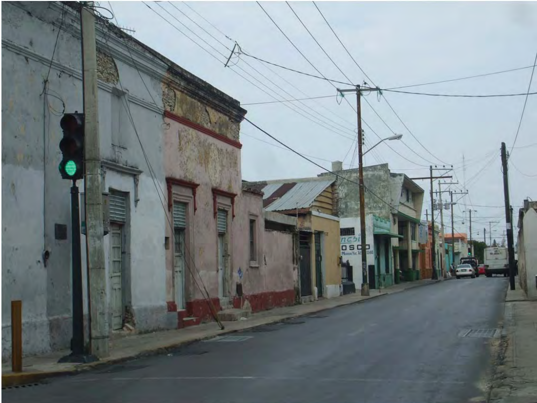
Imagen 21. Soportes de estructuras urbanas aéreas en Santiago. Foto: R. Canché
