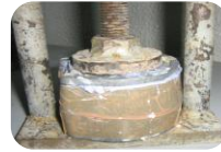
Fig. 107 COLOCACIÓN DE CONTRAMUFLA.
