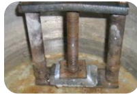
Fig. 95 COLOCACIÓN DE LA PRÓTESIS ENMUFLADA AL CALOR.
