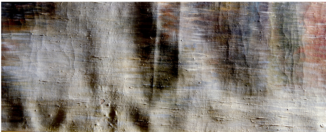
Fotografía con luz rasante que evidencia la deformación del soporte.
