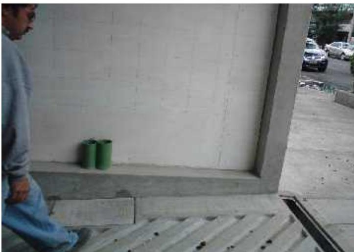
En esta foto se aprecian la obra civil terminada con registro y tubos de PVC para acometida subterránea.
