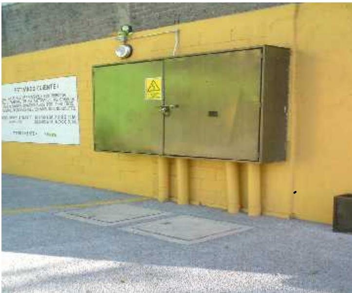
En esta foto se aprecian los registros y tubo de PVC para recibir acometida subterránea con un gabinete metálico para protección a los medidores. Las puertas metálicas no cuentan con un orificio con vista a los medidores por lo que no es accesible la toma de lectura a los equipos de medición.
