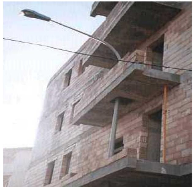
Figura 3.19 construcción realizada sin retirar el poste de alumbrado público
