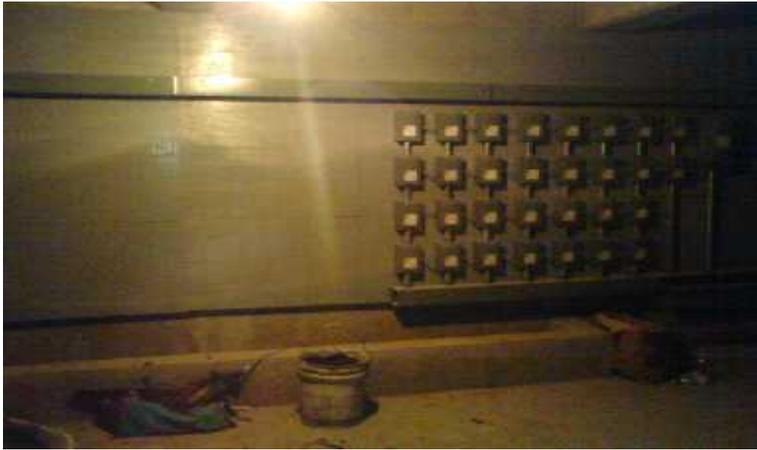
En esta foto se apreciar el tablero o murete con el ducto cuadrado embisagrado y el sardinel para paso de cables teniendo lo necesario para la instalación de los medidores en el nivel sótano.
