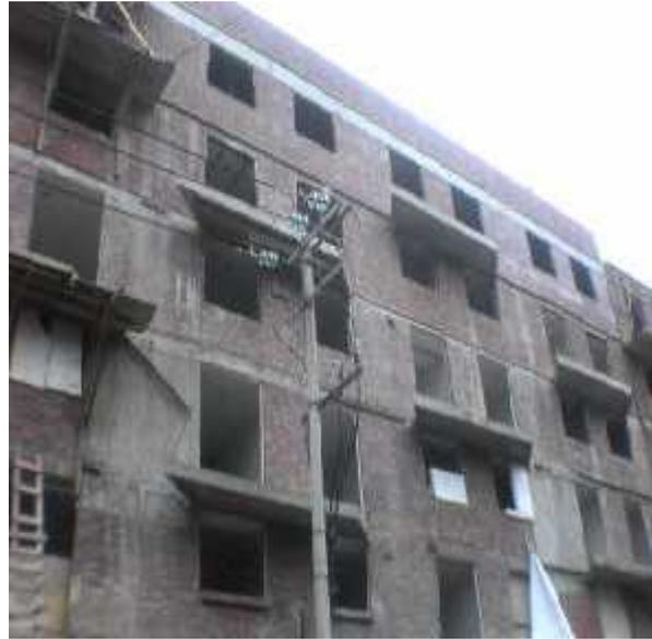
Figura 3.17 construcción de departamentos sin respetar las distancias mínimas entre línea de media tensión y la construcción
