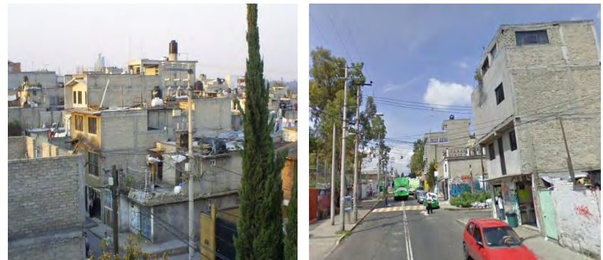
VIVIENDAS AUTOCONTRUIDAS SIN ORDENAMIENTO
