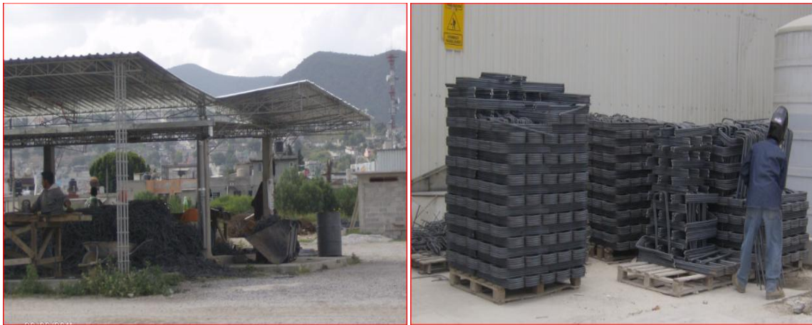
Habilitación de acero
