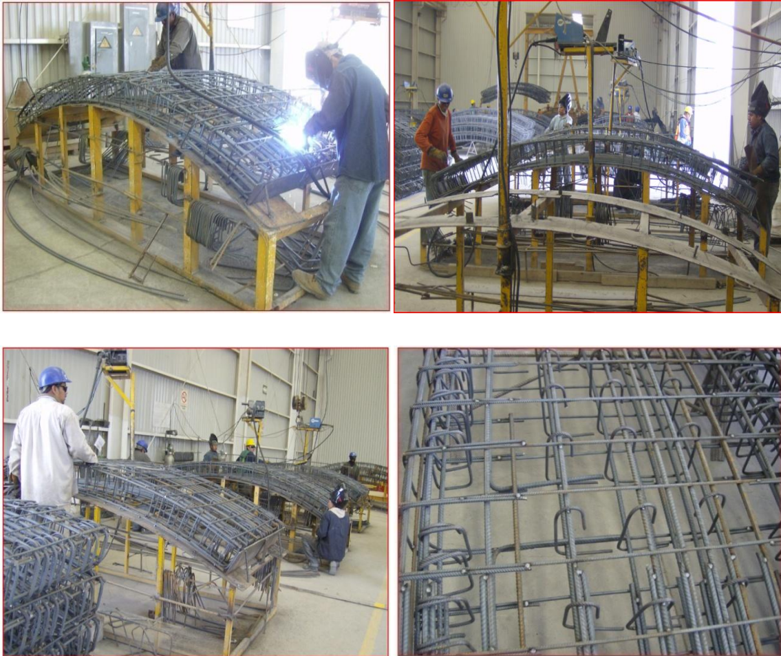
Ensamble de parrillas y cadenas para formar el alma de la dovela
