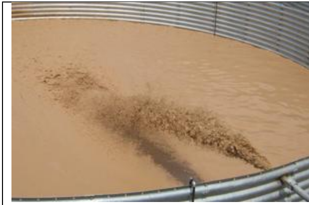
Contenedor de lodos bentoníticos en la lumbrera 20
