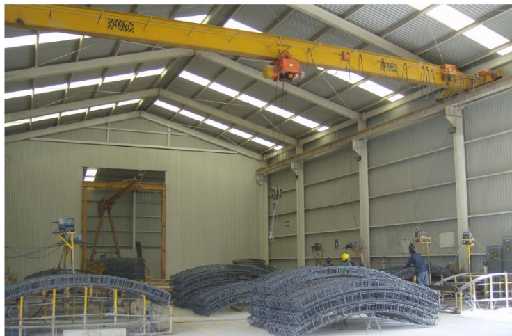
Grúa viajera tipo monopuente con capacidad para 5 toneladas de la marca HAWI. Utilizada para trasladar el acero de la dovela procedente de las mesas de habilitado, hacia la mesa giratoria
