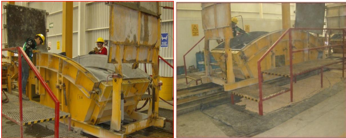
Limpieza de moldes
