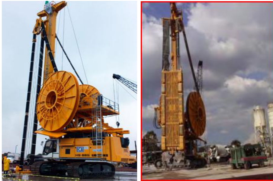
La hidrofresa, en la excavación en la lumbrera 20 del Túnel Emisor Oriente. Su brazo es capaz de perforar de manera vertical hasta 125 m.
