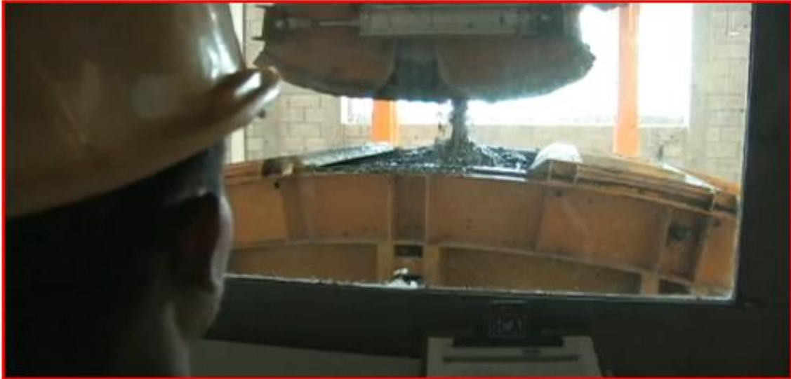
Cámara de colado
