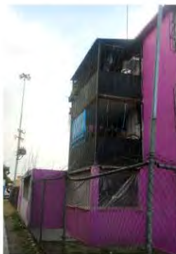
19. Ampliación área de lavado en tres niveles.
