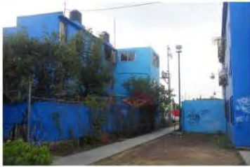
25. Ampliación del área de lavado edif. 16-H, 16-E
