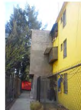
36. Ampliación del área de lavado en los tres niveles del edif. 18-D
