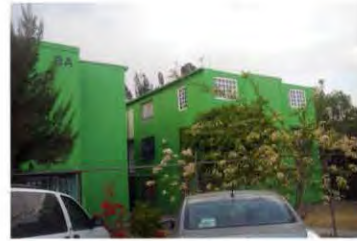
75. Ampliación de vivienda en los tres niveles del edif. 8-A
