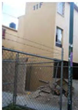
1. Ampliación de vivienda
