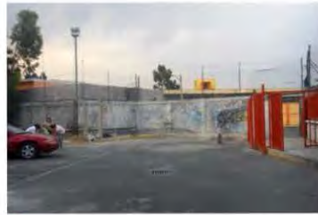
77. Acceso vehicular clausurado
