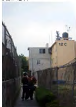
7. Enrejado delimitante de andadores
