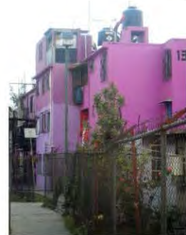
15. Ampliación de vivienda en cuatro niveles, edif. 13-F
