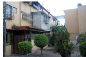
84. Edif.11-B. Ampliación de áreas de lavado en dos niveles
