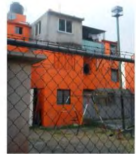
57. Edif. 3-D ampliación de vivienda
