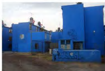
23. Cisterna, edif. 8-E
