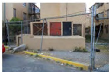
10. Cisterna enfrente del edif. 12-A
