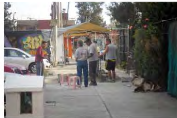
44. Autoconstrucción de ampliación
