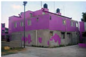
16. Ampliación de vivienda edif. 13-F
