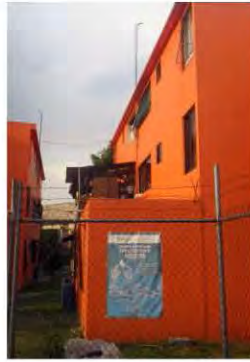
62. Ampliación edif. 4-J
