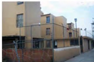
11. Ampliación de vivienda
