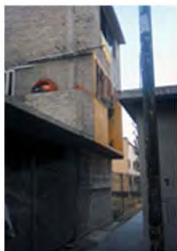
4. Ampliación de vivienda edif. 12-A
