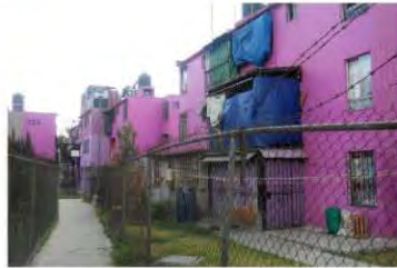
14. Andador enrejado y ampliación de vivienda edif. 13-E
