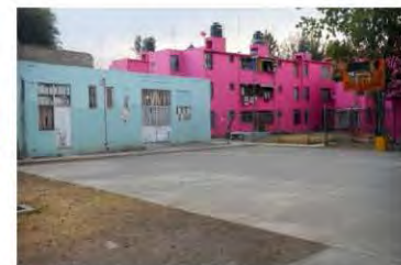
48. Casa de la cultura abandonada, construida posterior a la U.H.F.
