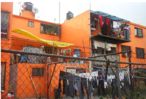
Ejemplos de ampliaciones a las viviendas dentro de la Unidad Habitacional Fiviport
