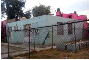
49. Casa de la cultura abandonada, construida posterior a la U.H.F.
