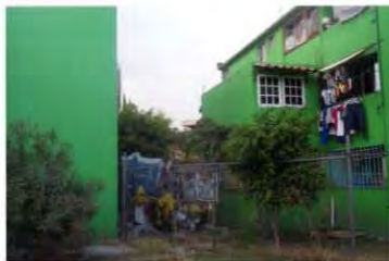
79. Edif. 9-E Ampliación de área de lavado
