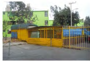
66. Rejas de estacionamiento
