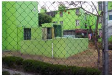
68. Edif. 6-B. Cisterna
