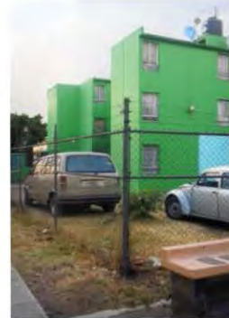
81. Área permeable como estacionamiento
