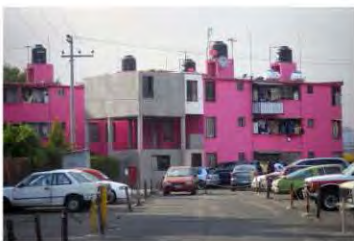
46. Ampliación de vivienda edif. 2-A
