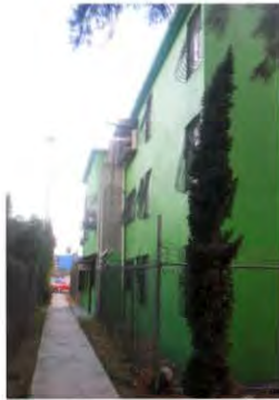
76. Andador vista del edif. 8-A
