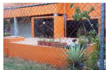
60. Edif. 4-J. Cisterna como jardinera
