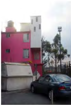
52. Ampliación de tablaroca edif. 2-J
