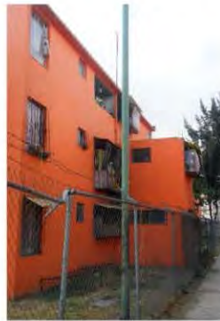
56. Edif. 3-H Enrejado y ampliación
