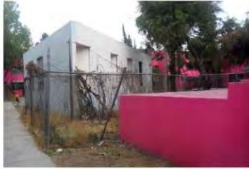
50. Cisterna y casa de la cultura abandonada
