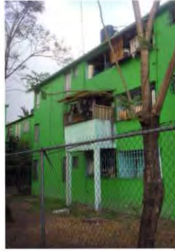
74. Ampliación edif. 8-A segundo nivel
