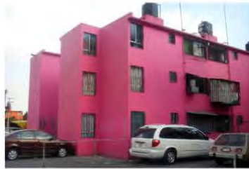
53. Edificio 2-A estacionamiento a nivel de edificio
