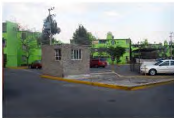
67. Cabina en área permeable
