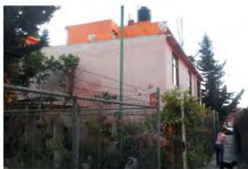
59. Edif. 4-J. Ampliación de vivienda y apropiación del espacio público
