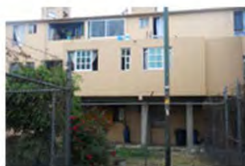
6. Ampliación de vivienda en el segundo nivel, edif. 12-J
