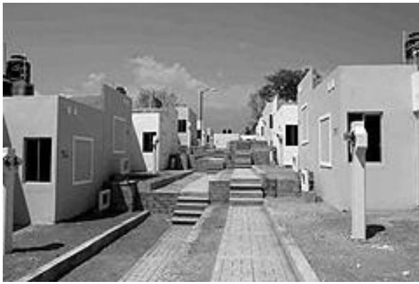
Vivienda del FONHAPO
