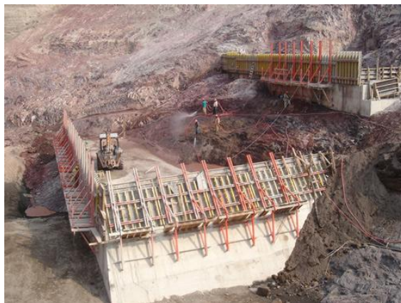
fig. 2.20 ETAPA DE CONSTRUCCIÓN DE PRESA FRANCISCO J. MUJICA
