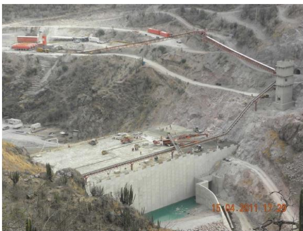
PANORAMICA DE COLOCACION DE CCR EN CORTINA
