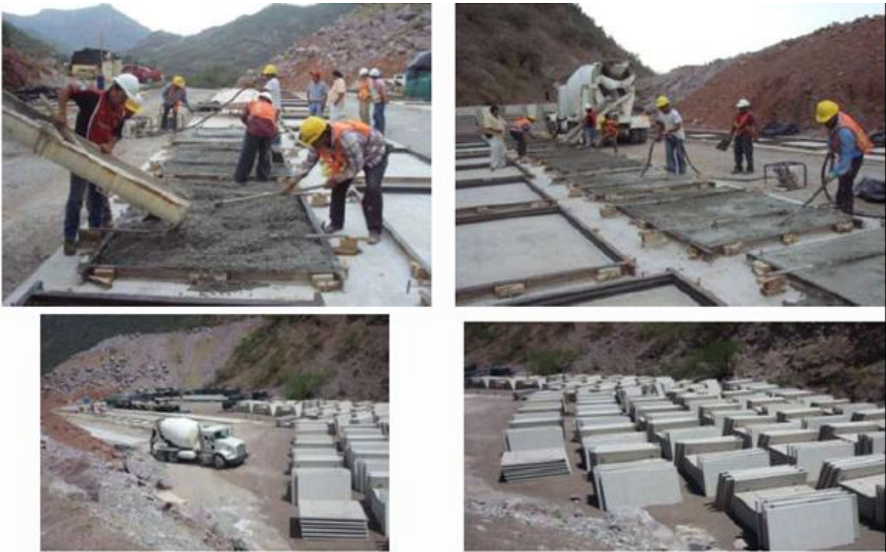
FIG.5.34 FABRICACION DE ELEMENTOS PREFABRICADOS CON CONCRTEO CONVENCIONAL
