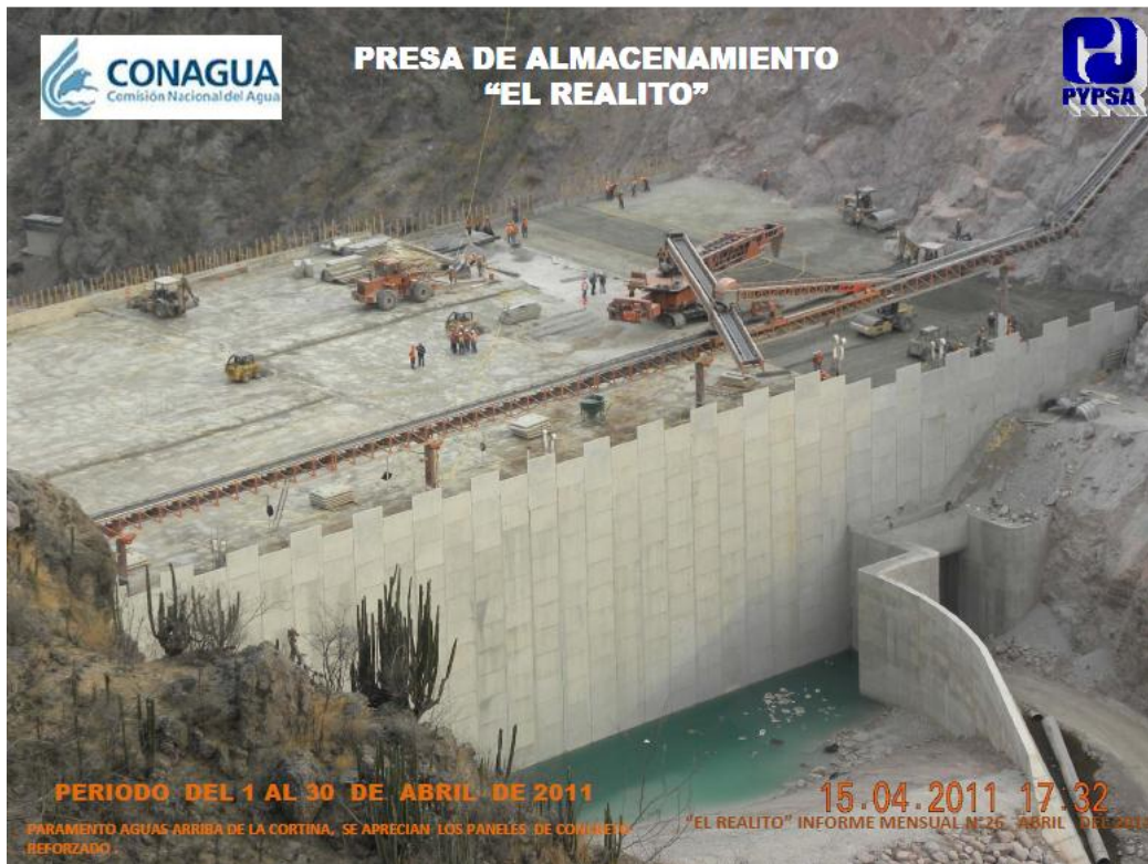
FIG. 5.64 AVANCE FISICO AL 30 DE ABRIL DEL 2011
