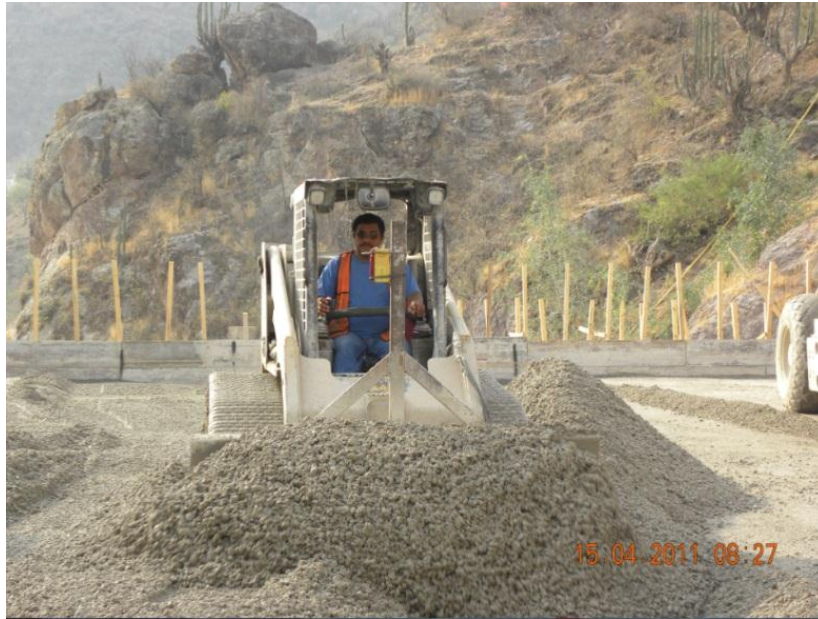
FIG. 5.55 ACOMODO Y EXTENDIDO
