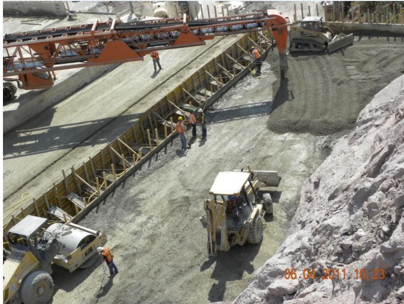
FIG. 5.49 PROCESO DE COLOCACION Y EXTENDIDO DE CCR
