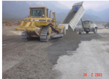
fig. 2.15 BULLDOZER EXTENDIENDO EL CCR EN BORDO DE PRUEBA
