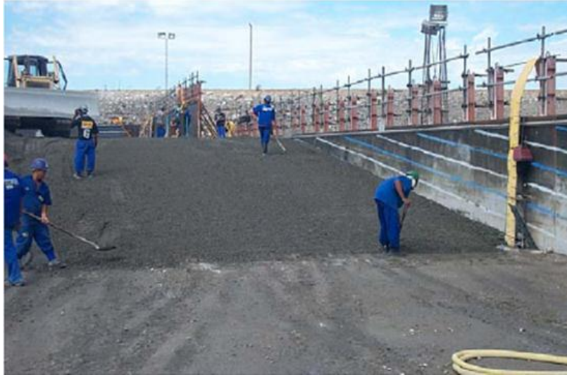
FIG. 4.31 CONTROL DE ALTURA DE CAPAS CON MARCAS PINTADAS EN LA CIMBRA
