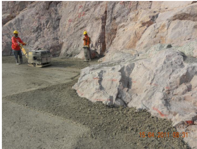
FIG.5.50 EQUIPO LIGERO DE COMPACTACION EN LAS ORILLAS
