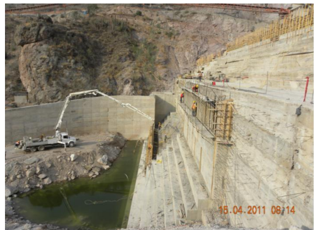
FIG. 5.37 COLADO DE CONCRETO CONVENCIONAL
