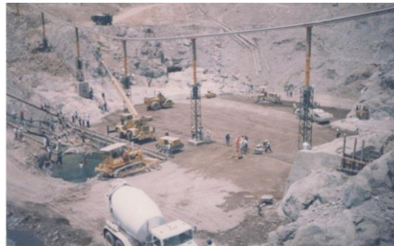
FIG. 2.34 PANORÁMICA DE CONSTRUCCIÓN
