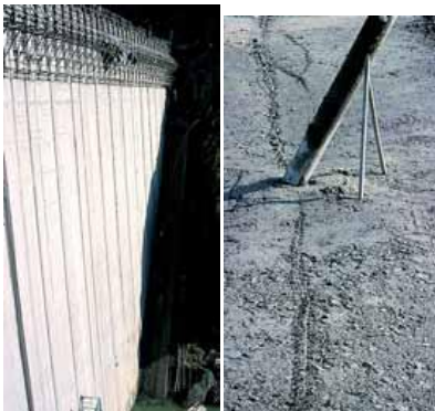
FIG. 4.34 EN LA PRESA MIEL 1.COLOMBIA EXISTEN 17 JUNTAS DE CONTRACCION TRANSVERSALES EN TODO EL CUERPO DE LA PRESA ESPACIADAS CADA 17,5 M, CON SELLOS DE PVC ALEDAÑOS A LA CARA DE AGUAS ARRIBA Y ADEMÁS UNA JUNTA LONGITUDINAL DIAGONAL PARALELA A LA CARA AGUAS ABAJO. LA JUNTA LONGITUDINAL SE CONSTRUYE DE MANERA SIMILAR, COLOCANDO TIRAS DE GEO-MALLA EN LUGAR DE LÁMINAS.
