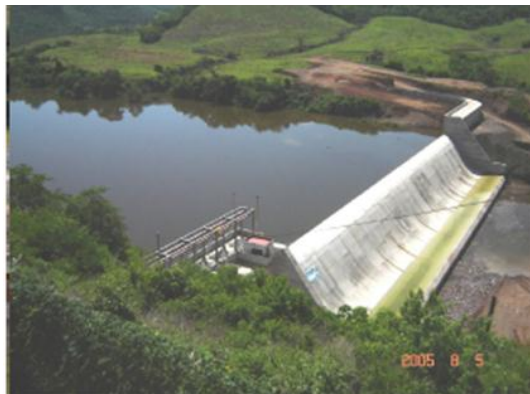
Fig.2.24 PRESA AMATA SINALOA, MEXICO.
