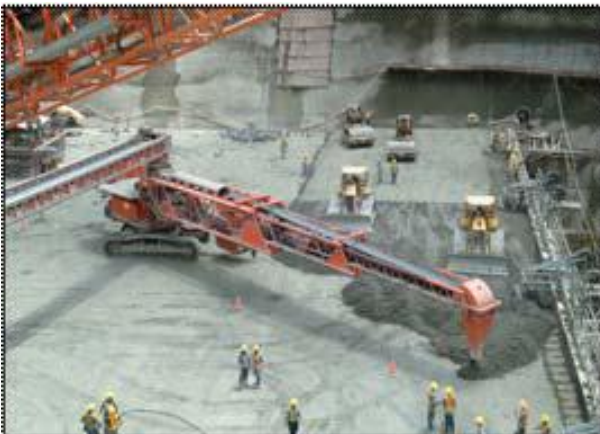
FIG. 2.78 UTILIZACIÓN DEL CRAWLER Y DE LA GRÚA POTAIN MD-1100
