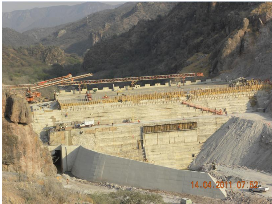
FIG.5.1 PRESA DE ALMACENAMIENTO EL REALITO EN CONSTRUCCION
