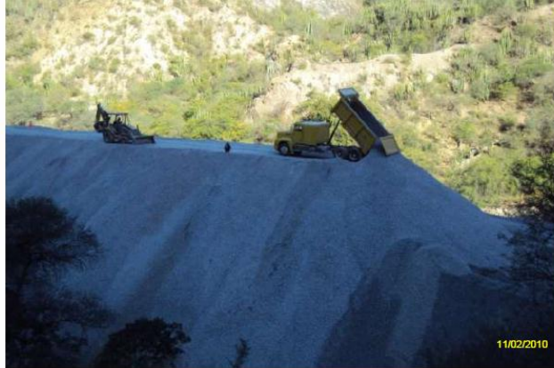
ALMACENAMIENTO DE AGREGADOS
