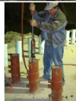
FIG. 3.29 SUPERVISION Y CONTROL DE CALIDAD
