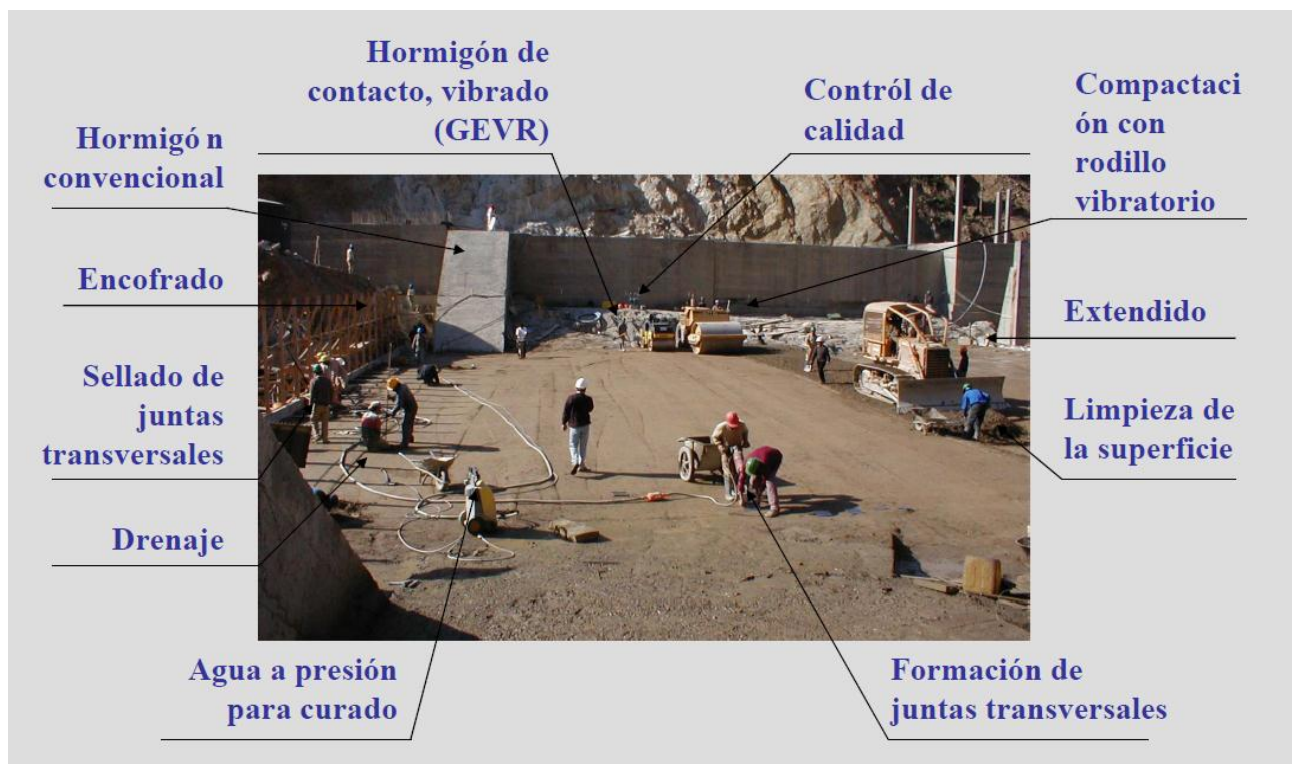
. FIG. 4.23 PROCESO DE CONSTRUCCIÓN DEL CCR
