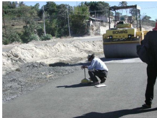
FIG. 4.61 COMPACTACION CON RODILLO LISO Y DETERMINACION DE DENSIDAD
