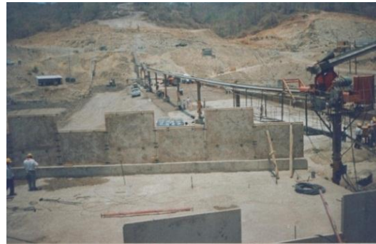
FIG. 2.45 CIMBRA PERMANENTE EN TALUD AGUAS ARRIBA
