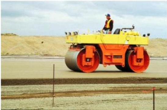
FIG. 4.12 ES RECOMENDABLE CONSIDERAR CONCRETO CONVENCIONAL, VIBRADO DE LA MANERA USUAL, EN TODOS LOS LUGARES EN QUE NO PUEDE LLEGAR LA COMPACTACION CON RODILLO, Y ES SUMAMENTE IMPORTANTE LA INTEGRACION INTIMA DE ESTE CONCRETO CON EL CCR DE LA CONSTRUCCION GENERAL
