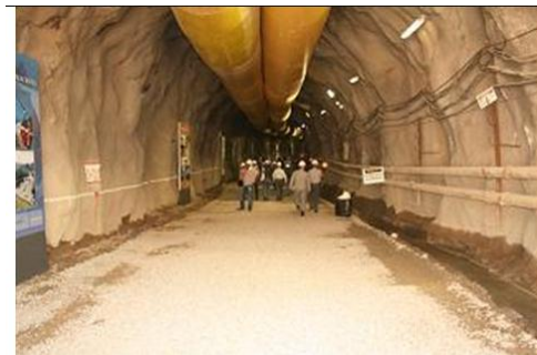
Túnel principal inaugurado del Proyecto Hidroeléctrico Palomino
