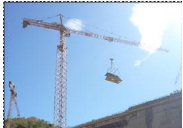
FIG. 2.78 UTILIZACIÓN DEL CRAWLER Y DE LA GRÚA POTAIN MD-1100
