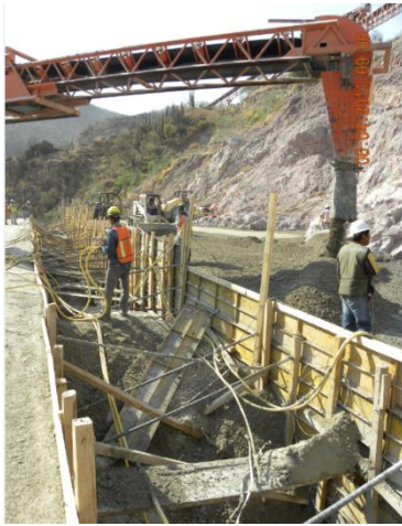
FIG. 5.59 CONSTRUCCION DE LA GALERIA CON FORMAS METALICAS Y RELLENO DE ESPACIOS CON GRAVA O ARENA
