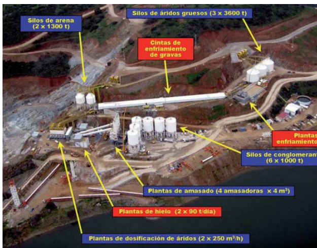
FIG. 2.55 VISTA AÉREA DE LAS INSTALACIONES PARA FABRICACIÓN Y ENFRIAMIENTO DEL CCR
