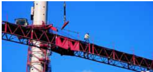
FIG. 2.97 TORRE GRUA CON ALTURA DE 230 m
