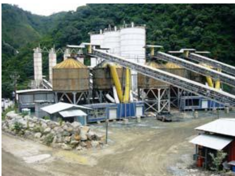
FIG. 2.75 PLANTA BETONMAC PARA PRODUCCIÓN DE RCC
