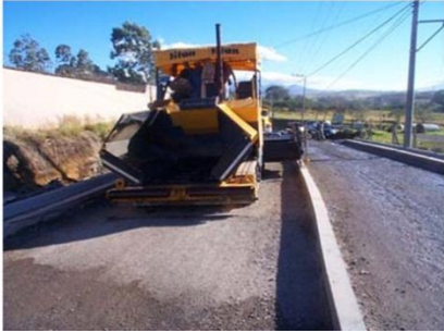
FIG. 4.8 BACHEO EN VIAS CON CCR
