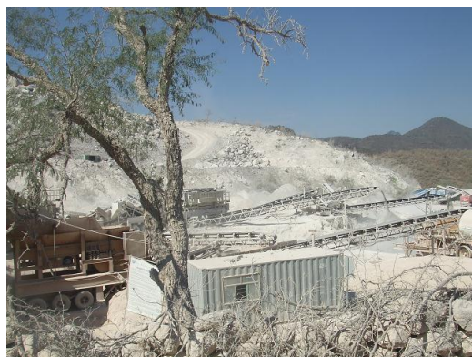
FIG.5.25.1 BANDAS EN PLANTA DE TRITURACION
