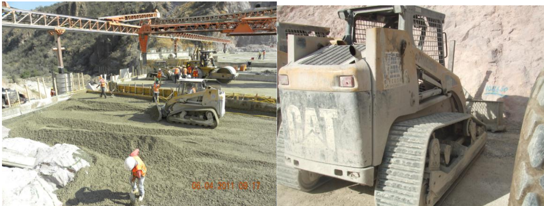
FIG. 5.46 EQUIPO LIGERO PARA EXTENDIDO DE CCR.
