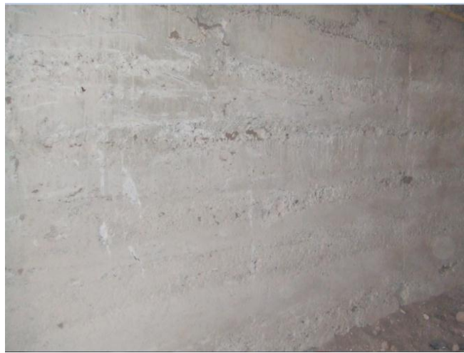
FIG. 5. 51 SE APRECIAN LAS CAPAS DE CCR EN SUPERFICIE INTERIOR EN GALERIAS
