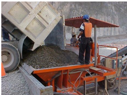
fig.2.16 VACIADO DE CCR EN TOLVA DEL AUGERMAX
