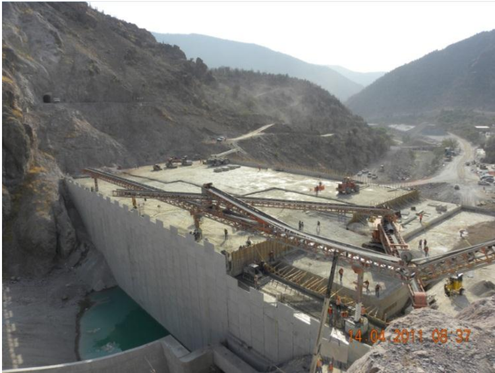
FIG.5.31 AVANCE AL 14 DE ABRIL DEL 2011
