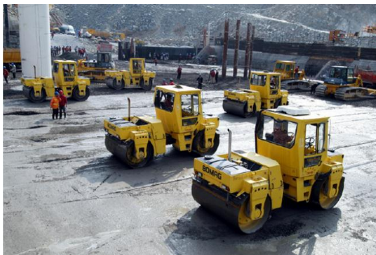
FIG. 4.41 CONSTRUCCION CON RODILLOS VIBRATORIOS
