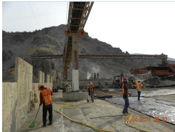
FIG. 5.30 LIMPIEZA DE SUPERFICIE
