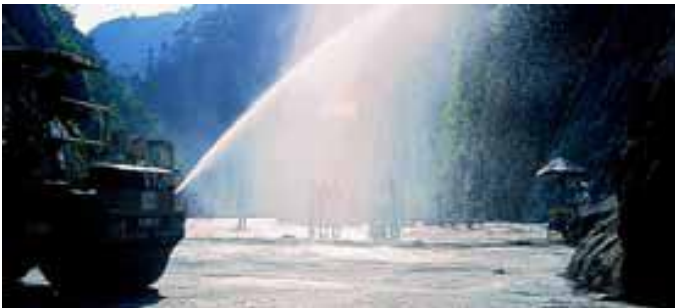
FIG. 3.7 PROCESO DE CURADO
