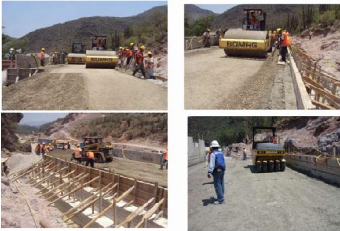
FIG. 5.8 COMPACTACION EN BORDO DE PRUEBA
