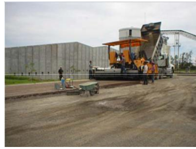
FIG. 4.7 MOVIMIENTO EN CONJUNTO DE LA MAQUINARIA PARA LA COLOCACION DE LA MEZCLA DE CCR
