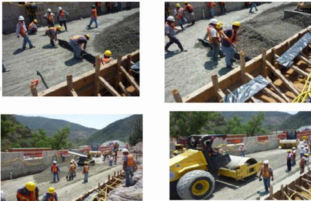
FIG. 5.7 COLOCACION DE JUNTA DE CONSTRUCCION EN BORDO DE PRUEBA
