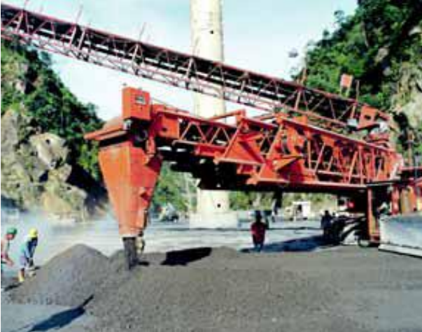
FIG. 4.32 EL CRAWL PLACER PERMITE UNA COLOCACIÓN RÁPIDA Y EN ESPESORES CASI IGUALES A LOS NECESARIOS POR CAPAS PARA SER EXTENDIDO RÁPIDAMENTE CON EL BULLDÓZER . PRESA MIEL 1.COLOMBIA
