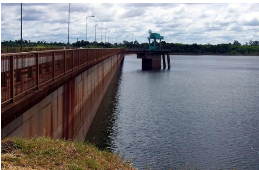
FIG. 2.50 LA PRIMERA DE ESTE TIPO EN ARGENTINA. ESTRUCTURA DE GRAVEDAD ALTURA 80 M. LARGO DE CORONAMIENTO 687 M. VOLUMEN TOTAL 600 000 M3 PARAMENTO AGUAS ARRIBA EN VERTICAL Y EL DE ABAJO CON PENDIENTE 1 (VERT): 0.8 ( HORIZ).
