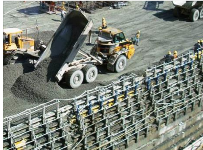
FIG. 4.39 SISTEMA DE FORMALETA AUTOTREPANTE
