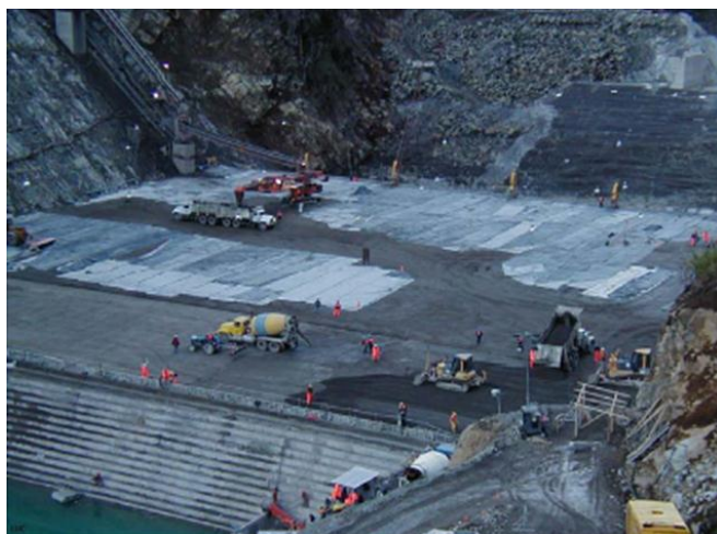
FIG.2.83 USO DE MANTAS TERMICAS PARA PROTEGER SUPERFICIE DE CCR EXPUESTO.
