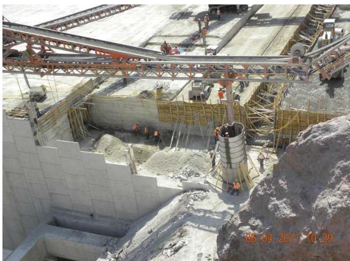
FIG. 5.58 CIMBRA EN GALERIA DE INSPECCION
