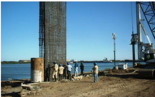
*Figura 4.47. Manejo de los armados.*
