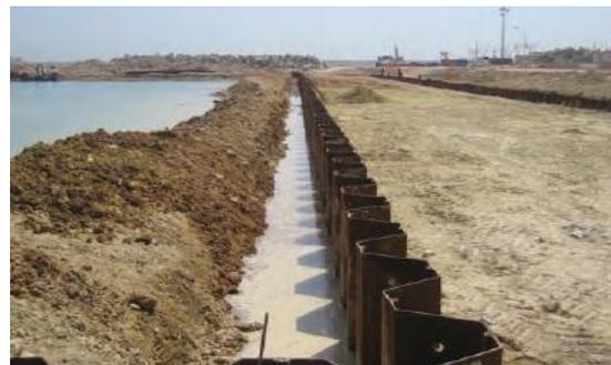
*Figura 4.40. Relleno en pantalla de tablestacas.*
