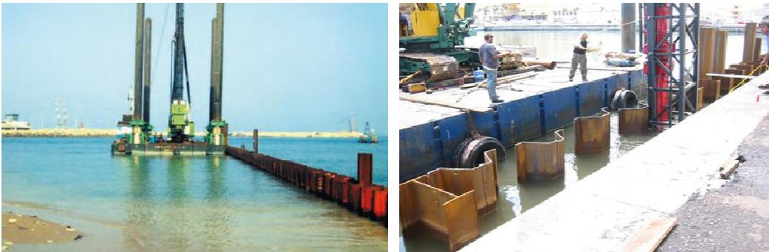
**Figura 4.34. Hincada de tablestacas con medios flotantes.**
