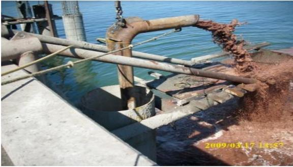
**Figura 4.57. Sistema air-lift**
