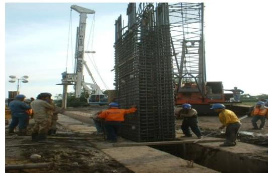
*Figura 4.48 Colocación en la zanja.
