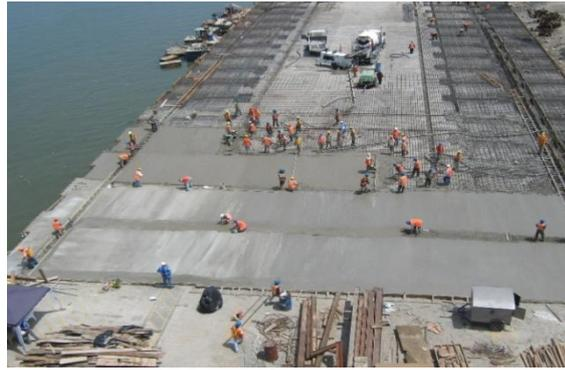
**Fig. 4.80. Colocación del concreto en losas**
