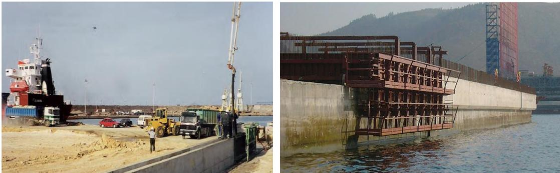
**Figura 4.32. Construcción de trabe longitudinal y cantil.**
