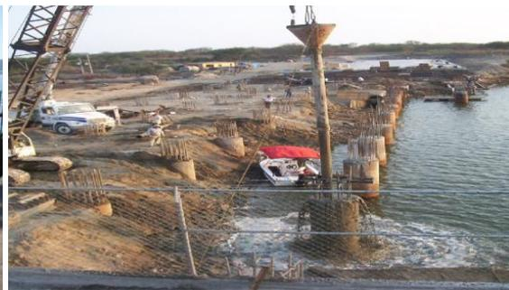
Figura 4.64. Colocación del concreto.
