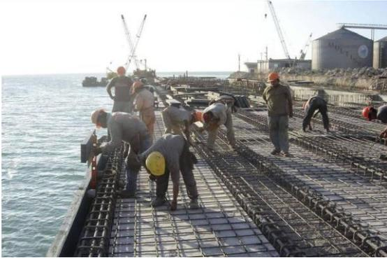
**Figura 4.79. Acero de refuerzo en losa y pantallas**
