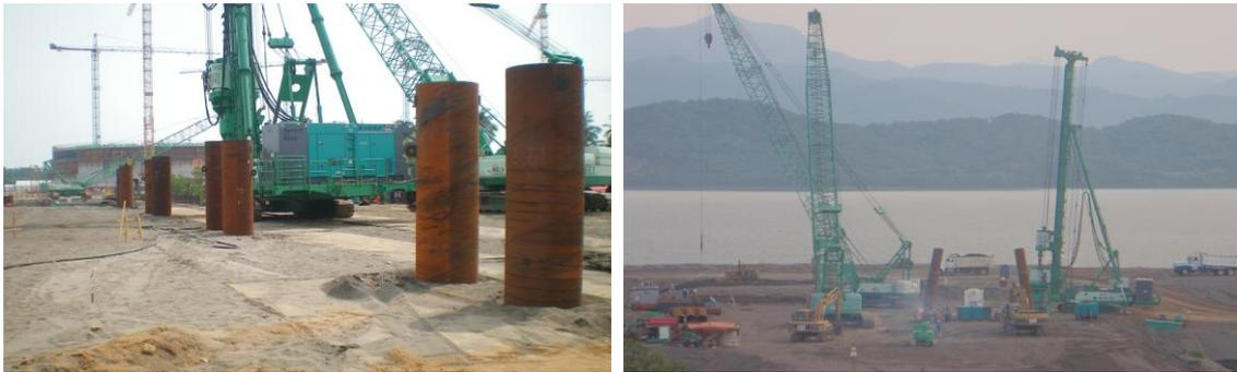
**Figura 4.75. Hincado de pilotes de acero**
