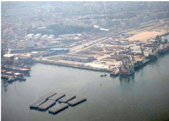
*Figura 4.27. Remolque del cajón.*
