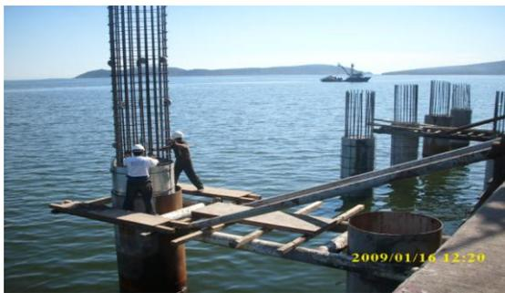
Figura 4.63. Colocación del acero de refuerzo.
