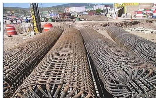
**Figura 4.61 Acero de refuerzo en pilas**
