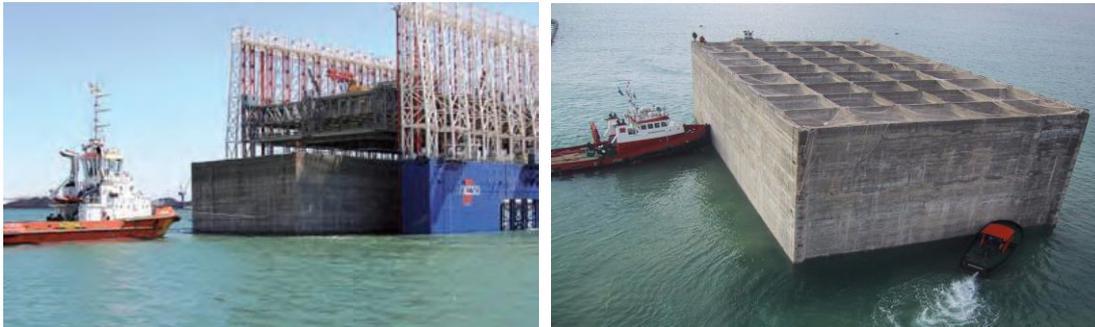
**Figura 4.26. Botadura del cajón.**
