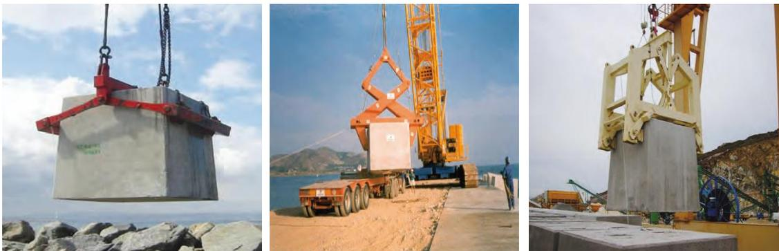
**Figura 4.9. Sistemas de manipulación de bloques.**
