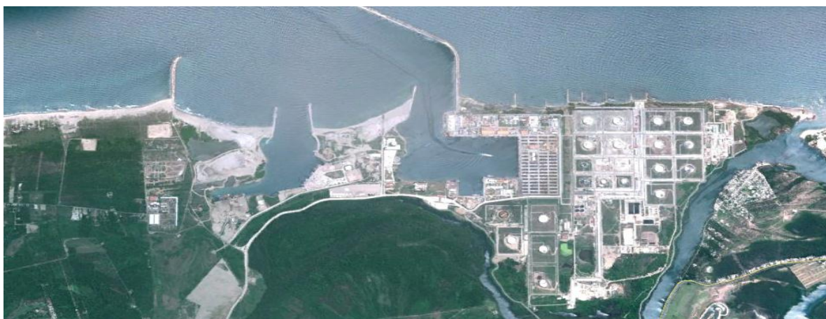
Ilustración 46: Fotografía satelital del puerto de Dos Bocas, Tabasco.
