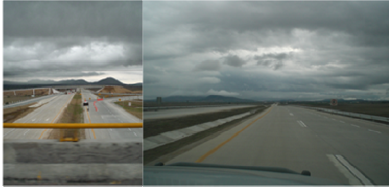
Figura 4.26 Tramo de Arco Norte entre Calpulapan y San Martín Texmelucan
