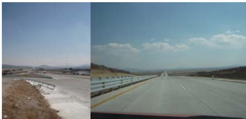
Figura 4.25 Tramo de Arco Norte entre Tulancingo y Calpulalpan
