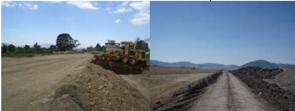
Figura 4.28 Tramo de Arco Norte entre Acambay y Jilotepec
