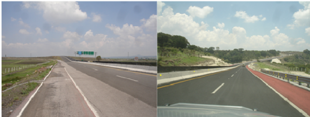
Figura 4.27 Tramo de Arco Norte entre México-Querétaro y Tula II
