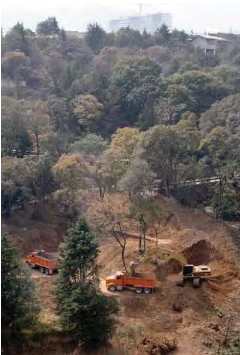
Imagen 11: El comienzo de la excavación para la construcción de lo que ahora conocemos en Santa Fe.
