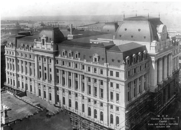
Imagen 18: Antes de la restauración
