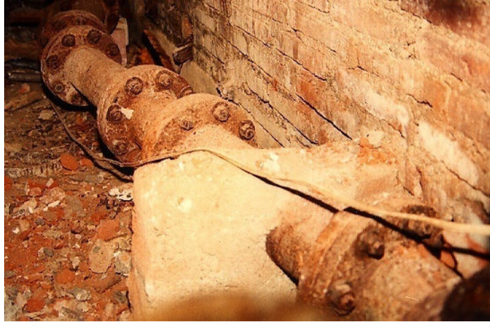
Figura 4 Efecto de la intemperie en una tubería
