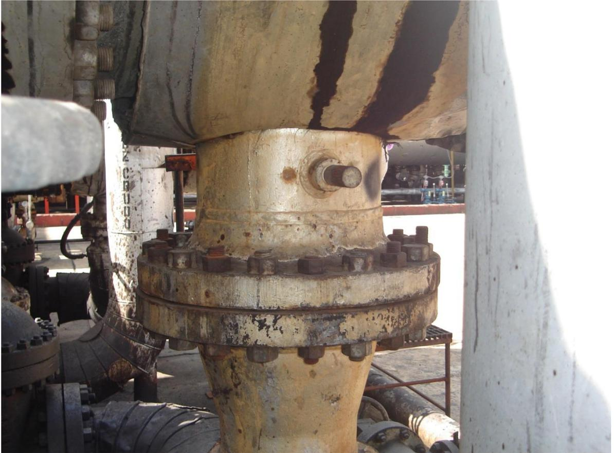
Figura 25. Brida inferior de un Cambiador de Calor.
