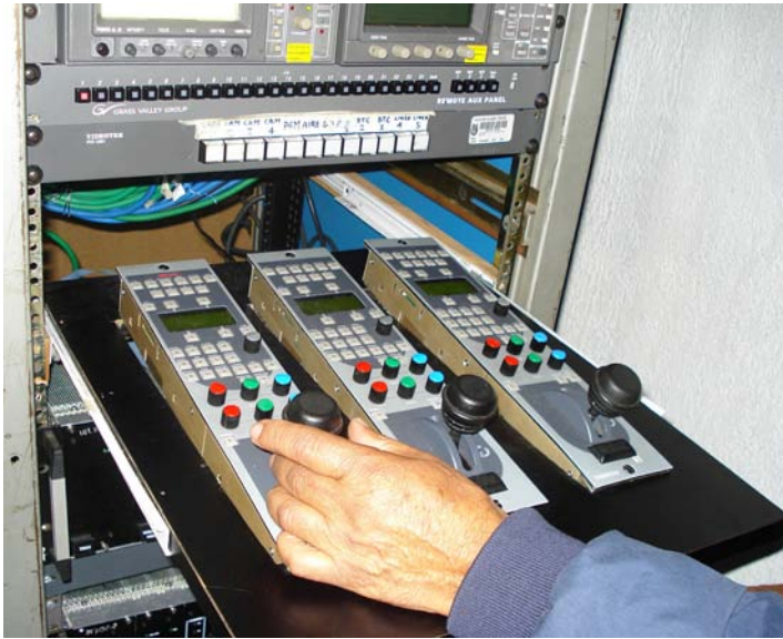
Control de iluminación de CCU.
