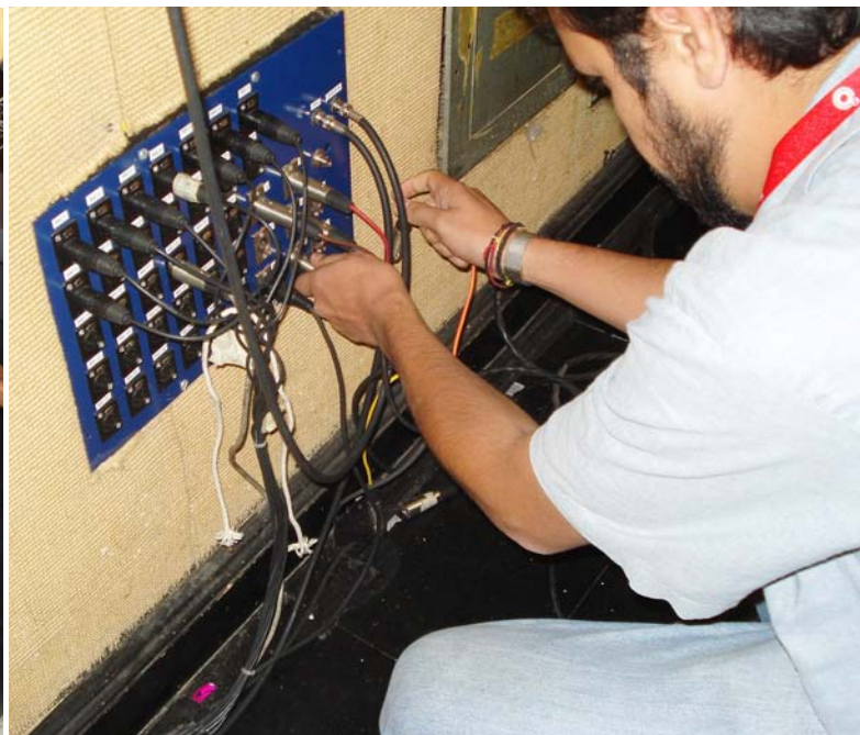
Jesús Torres, revisa que la fuente de poder (izq.) se encuentre encendida y que los micrófonos estén conectados al canal de audio que les corresponde.
