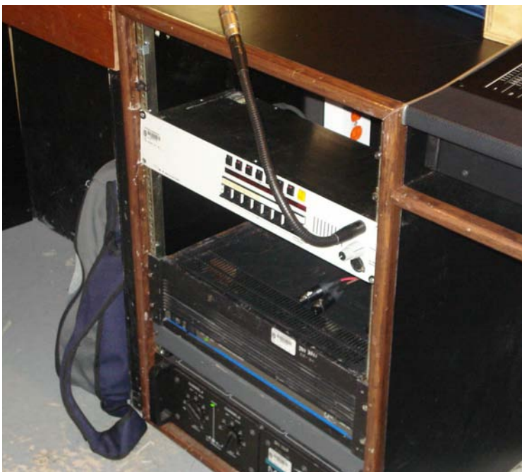
Jesús Torres, revisa que la fuente de poder (izq.) se encuentre encendida y que los micrófonos estén conectados al canal de audio que les corresponde.
