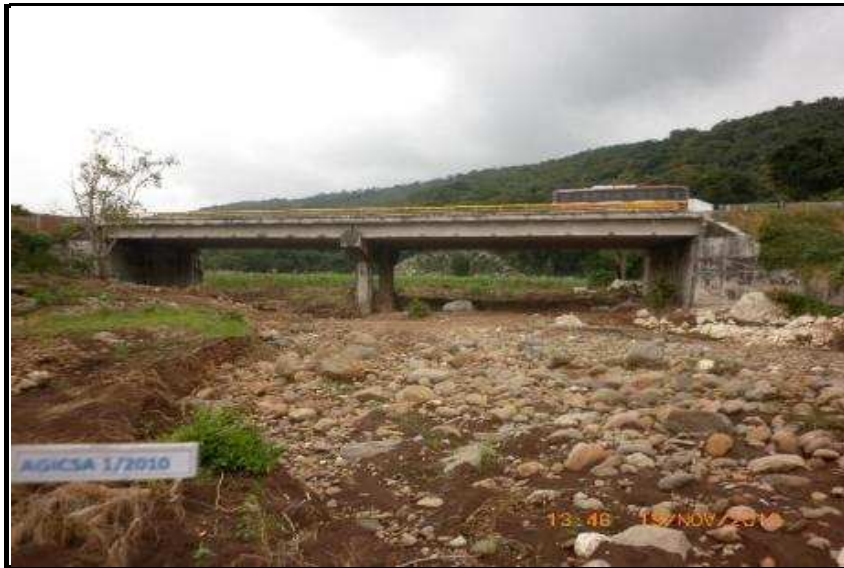
VISTA PANORAMICA DEL PUENTE ARROYO HONDO CPO. A
