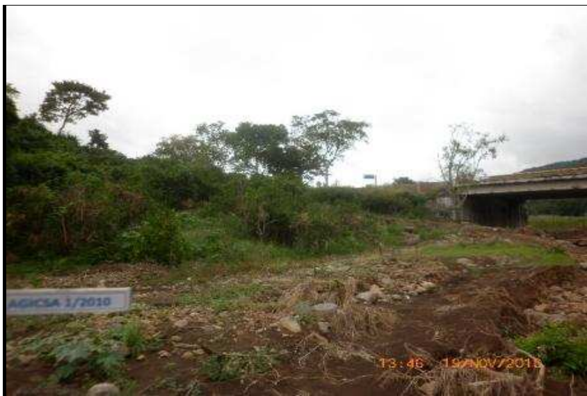
VISTA DEL ESTRIBO No. 1 Y ACCESO
