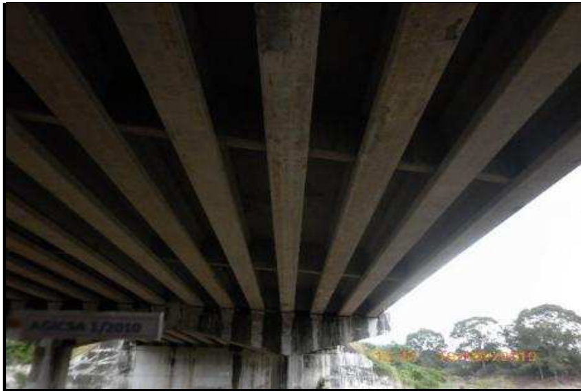
VISTA DE LAS TRABES DEL TRAMO 1-2, EN BUEN ESTADO.
