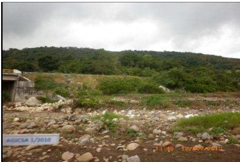
VISTA DEL ESTRIBO No. 3 Y EL ACCESO.
