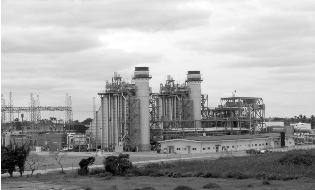
Figura 5. Producción de energía en una central de ciclo combinado. Central de ciclo combinado “Tuxpan V”, ubicada en Tuxpan, Veracruz. Foto: CFE
