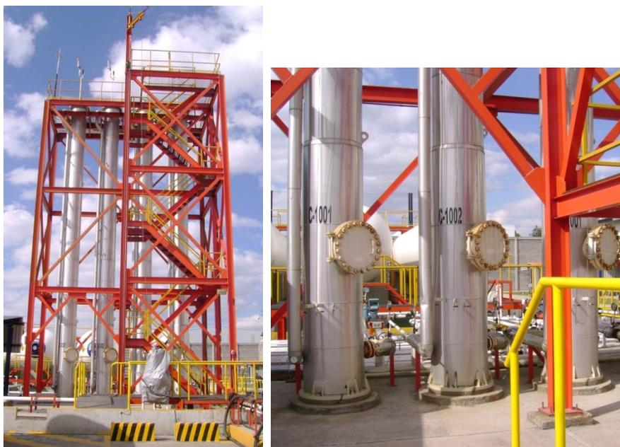
Figura 2.3. Fotografías de las columnas rellenas de zeolita utilizadas para la purificación del GLP y producción de gas n-butano y n-propano limpio
