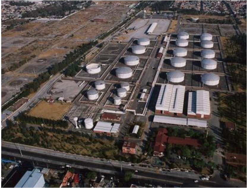
ILUSTRACIÓN 1. FOTO SATELITAL DE LA TERMINAL DE ALMACENAMIENTO Y REPARTO 18 DE MARZO DE PEMEX, UBICADA EN MEXICO D.F.
