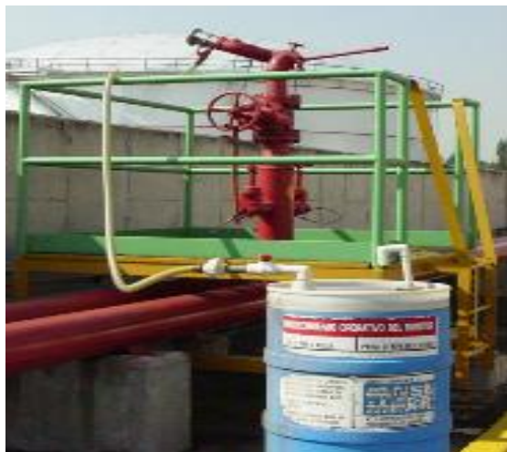
Ilustración 12. Hidrante monitor.
