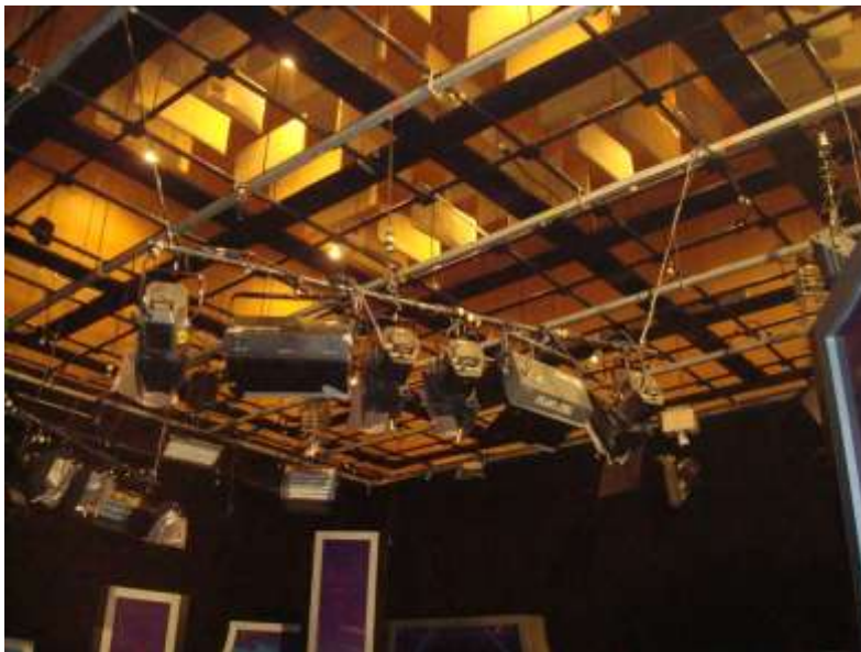
Ilustración 30 Listón en el set de TV con una carga máxima de luminarias.
