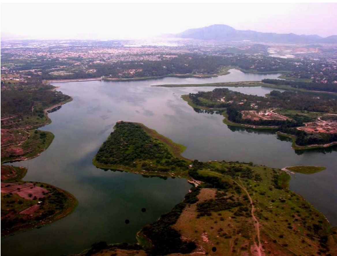
Figura 3. Foto panorámica del aspecto de la Presa de Guadalupe (foto de Dra. Patricia Ramírez Bastida).
