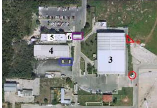
Figura 4.32 Zona de Carga Aeropuerto de Mérida
