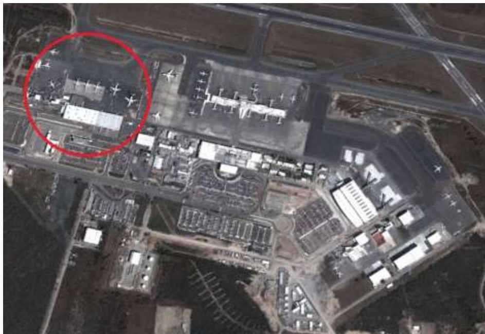
Figura 2.2 Terminal de carga Aeropuerto de Monterrey (MTY)
