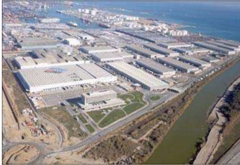
Figura 1.1 ZAL del Puerto de Barcelona
