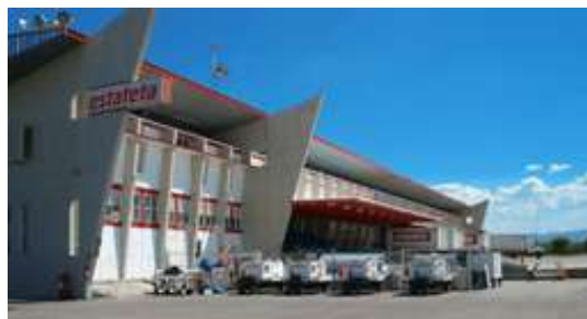
Figura 4.37 Terminal carga SLP Fuente: OMA
