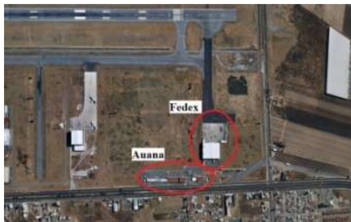
Figura 4.20 terminal de carga del AIT operador FedEx Fuente: Elaboración propia con base en Google Earth
