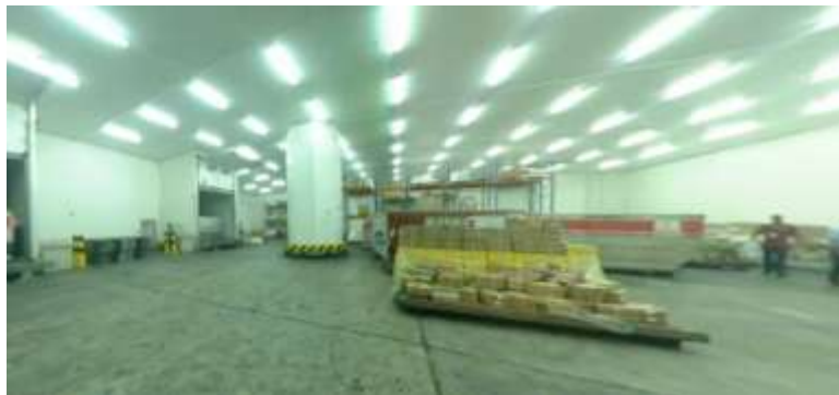
Figura 6.5.7 Área de refrigeración
