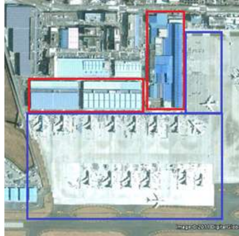
Figura 6.7.5 Zona de carga aeropuerto de Tokyo-Narita
