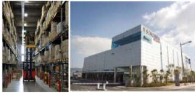
Figura 6.5.10 Instalaciones de Schenker Korea en el Airport Logispark
