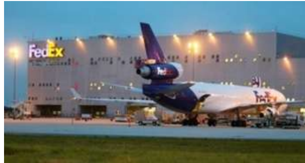
Figura 6.7.8 terminal FedEx aeropuerto Paris-CDG
