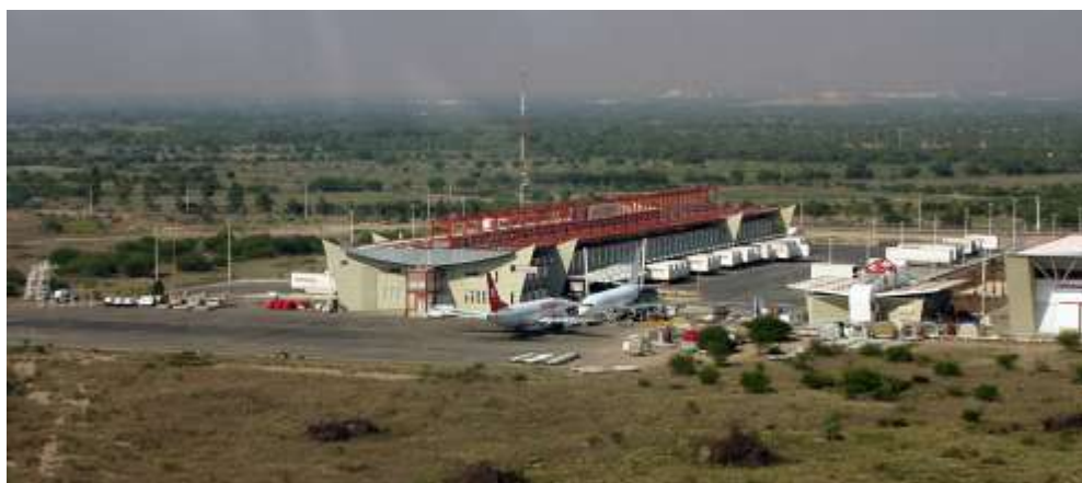
Figura 4.40 Terminal de carga aeropuerto de San Luis Potosí
