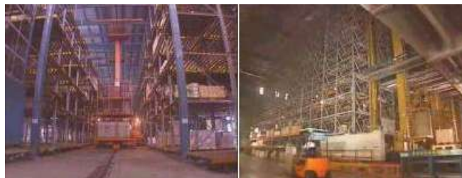
Figura 5.2.5.4 Equipo, Terminal EVERTER
