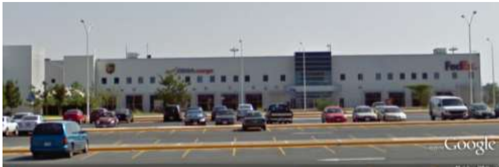
Figura 4.16 Frente de la terminal de carga Aeropuerto de Monterrey
