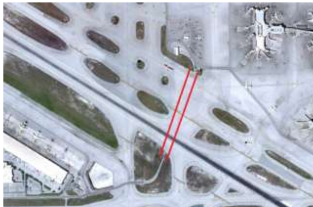
Figura 6.9.1 Túnel Aeropuerto Miami (MIA)
