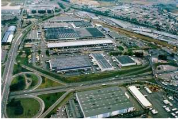
Figura 1.2 Vista superior de las instalaciones de Sogaris en París-Rungis
