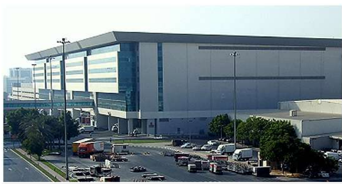
Figura 5.4.1.1 Megaterminal de carga Dubai Fuente: Emirates
