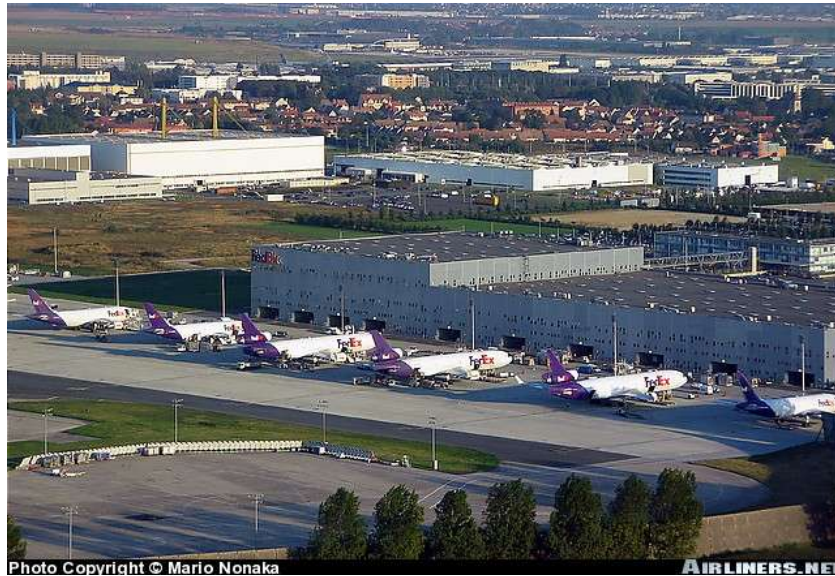
Figura 6.5.14 Terminal de carga FedEx, Aeropuerto Charles de Gaulle
