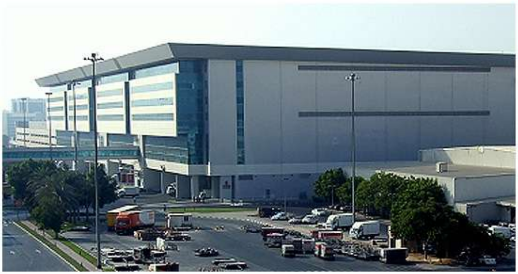
Figura 6.3.3 Mega-terminal de Emirates, Aeropuerto de Dubái
