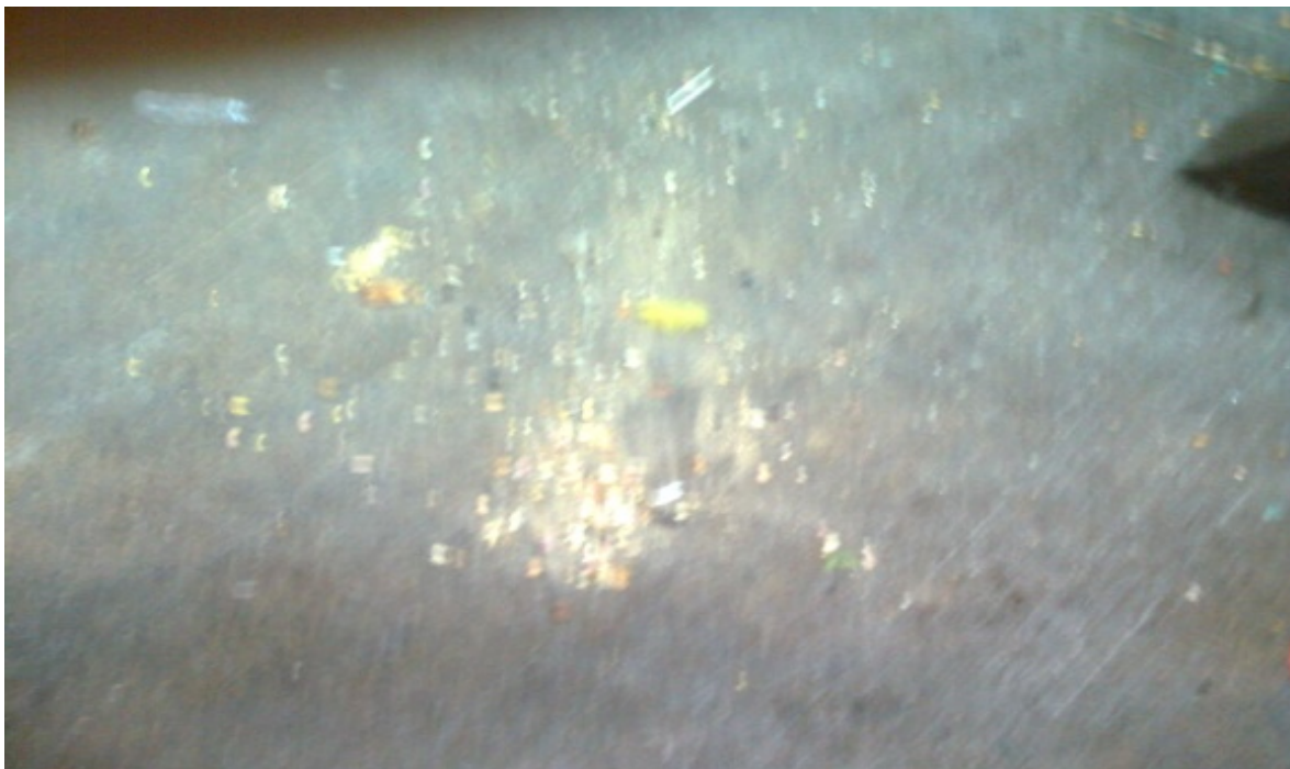
Figura 30. Evidencia de piso sucios en el local 2 de la Central de Abastos de Tultitlán
