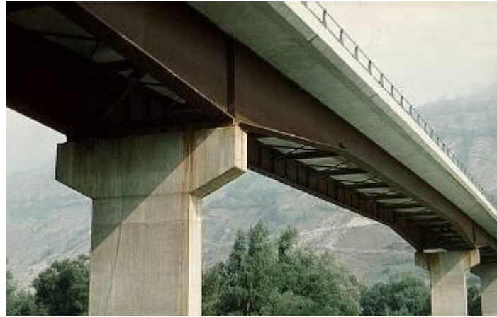
Puente mixto de acero y concreto armado.
