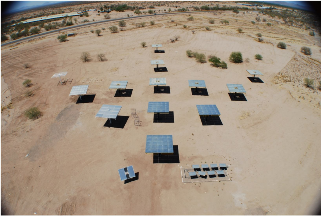
Figura 1.19. Vista Fish Eye del CPH en su primera etapa de construcción
