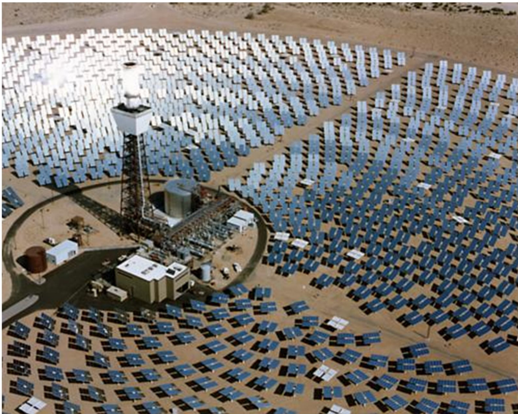
Figura 1.11. Planta SOLAR ONE ubicada en Barstow, California
