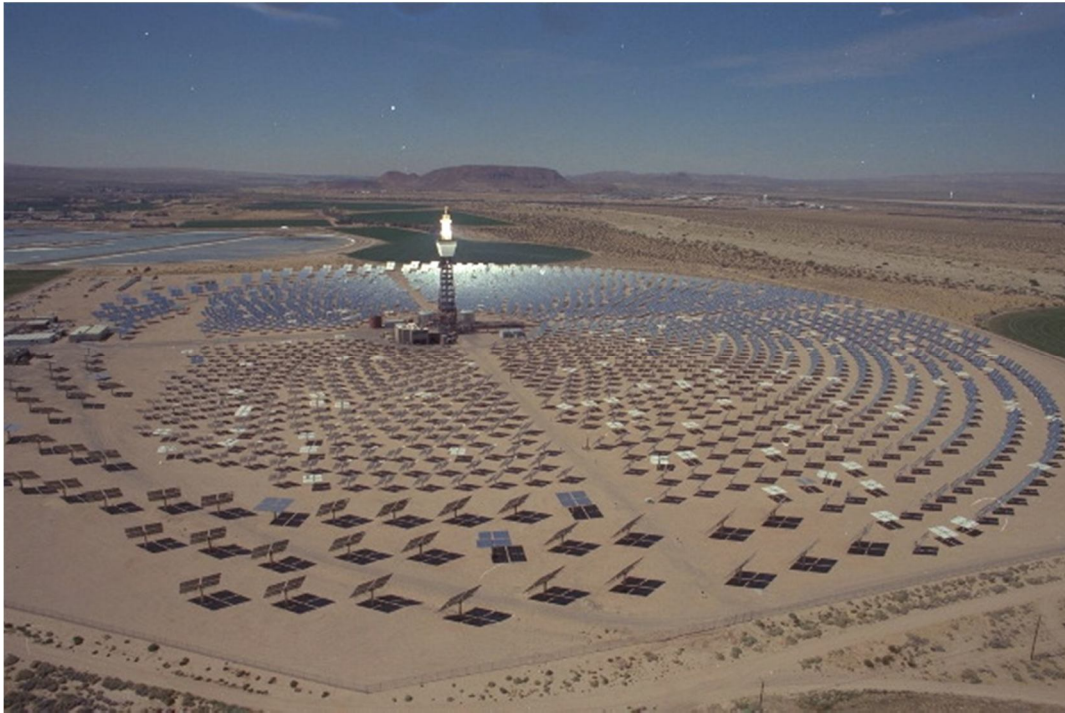
Figura 1.12. Planta SOLAR TWO, construida a partir de la SOLAR ONE
