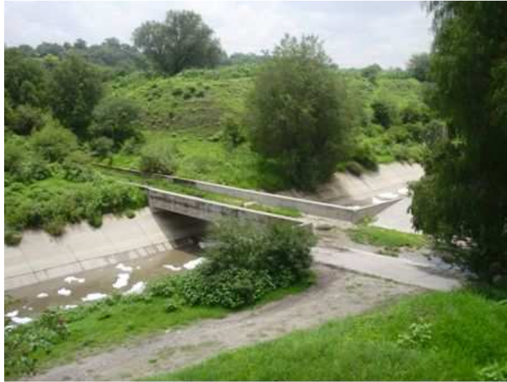
A 6.00 m DEL PUENTE – CANAL QUE SE MUESTRA EN LA IMAGEN DEL CANAL EL SALTO –TLAMACO, SE DEBERÁ INICIAR LA OBRA DE DESVÍO
