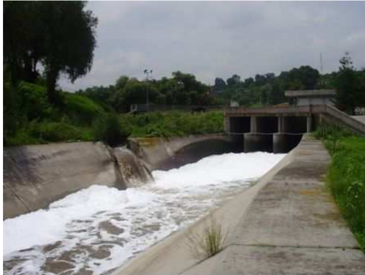
EN ESTA IMAGEN SE APRECIA LA SALIDA DEL SIFÓN, ALIMENTADO POR EL EMISOR CENTRAL, Y LAS COMPUERTAS DE CONTROL
