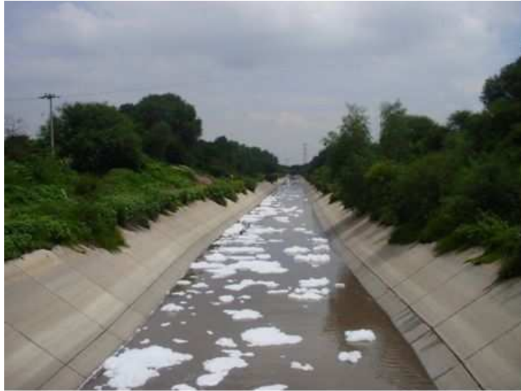
VISTA DEL CANAL EN LA ZONA, DONDE SE CONSTRUIRÁ LA OBRA DE TOMA DE LA PLANTA DE TRATAMIENTO DE AGUAS RESIDUALES DE ATOTONILCO
