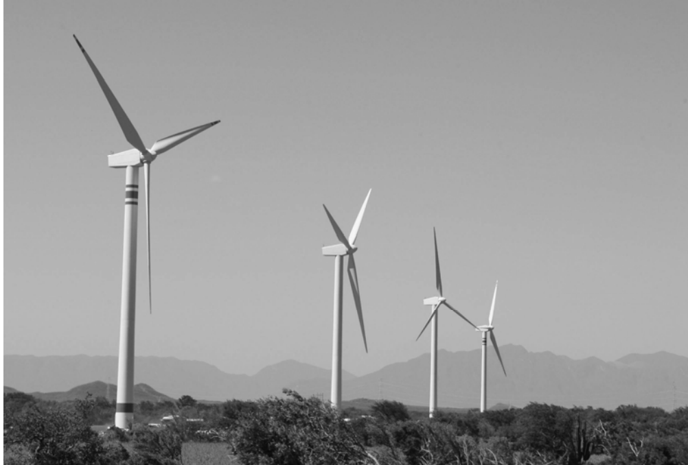
Fig. 2.1 La Ventosa, inaugurado en México, entre el istmo de el Golfo de México y el Pacífico, es el mayor parque eólico de América Latina con una potencia que podría alcanzar los 250 MW de electricidad con 167 turbinas
