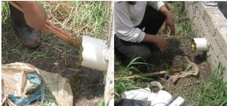
**Figura 8.** Introducción del inóculo de estiércol de res al biodigestor
