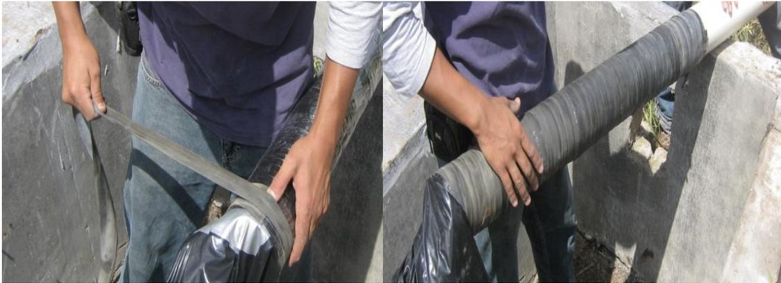
**Figura 8.** Amarre de los extremos con la cámara de llanta
