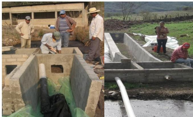
**Figura 4.** Construcción de la canaleta de contención
