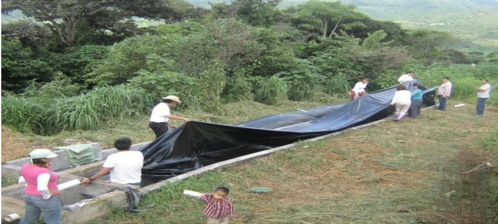
**Figura 6.** Instalación del biodigestor, dentro de la canaleta de contención
