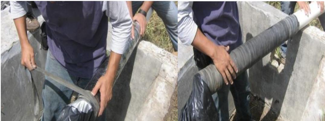
**Figura 7.** Amarres con las cámaras de llantas, en los extremos del digestor.
