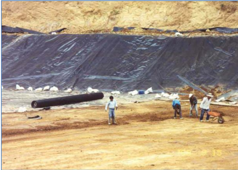
Figura 1.11 Preparación de un sitio de disposición (Wehenpohl y col., 2003)
