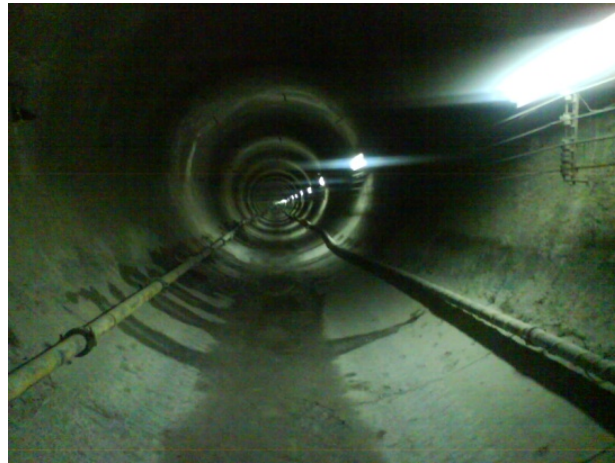
Fig. 4.2.12 Tramo revestido con un espesor de 30 cm
