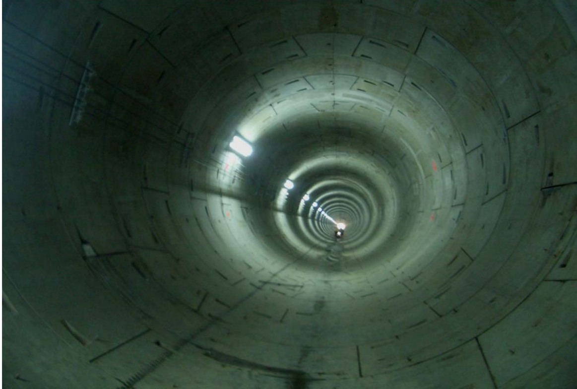
Fig. 4.1.14 Culminación de un tramo de revestimiento primario (dovelas de concreto)
