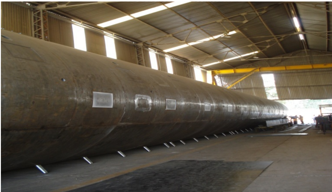
Fig. 2.5.3 Piernas de flotación de la cimbra.
