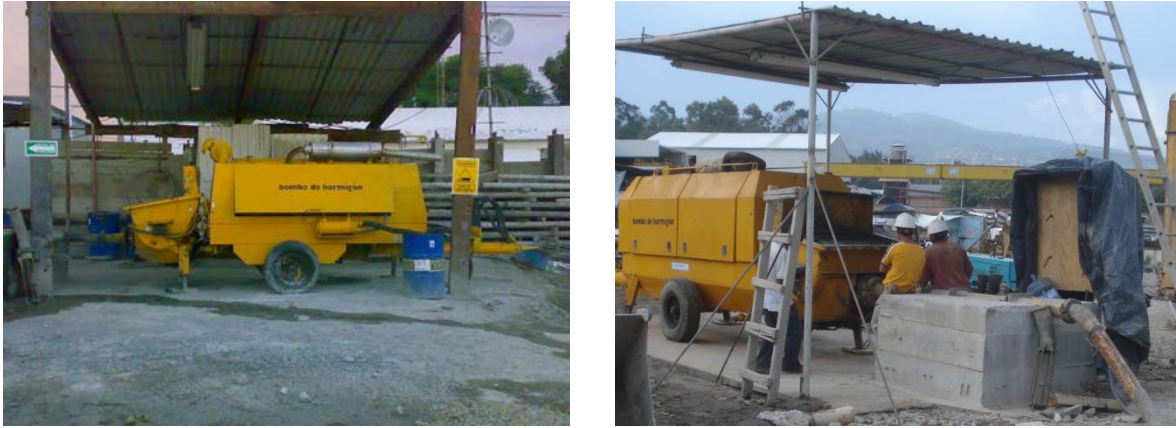
Fig. 4.2.11 Bomba para transporte de concreto al sitio de colocación
