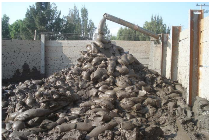
Fig. 2.3.3 Material rezagado con bomba de pistón
