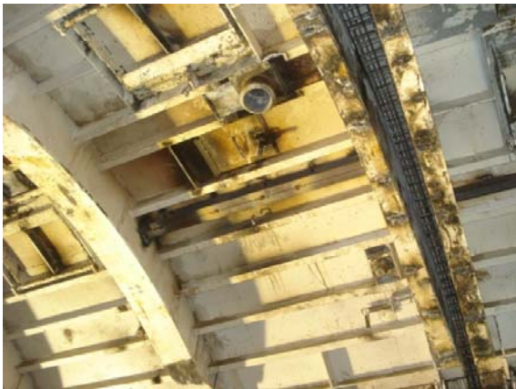
fig. 2.5.5 Vibradores para la cimbra
