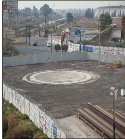
Fig. 2.1.1 Primera etapa, construcción de brocales provisionales
