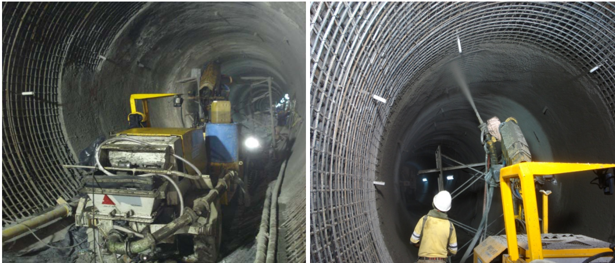
Fig. 2.5.13 Equipo para colocación de concreto lanzado
