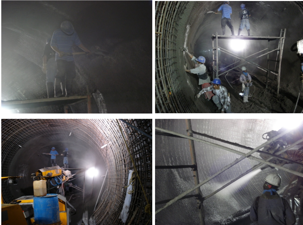
Fig. 4.2.15. Colocación de concreto lanzado
