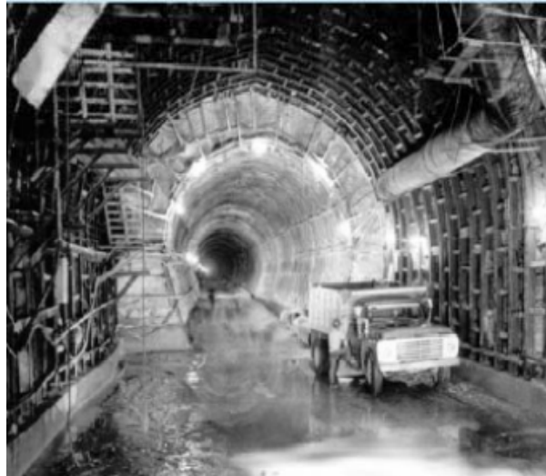
Fig. 1.2.2 Creación de una parte del sistema de alcantarillado.
