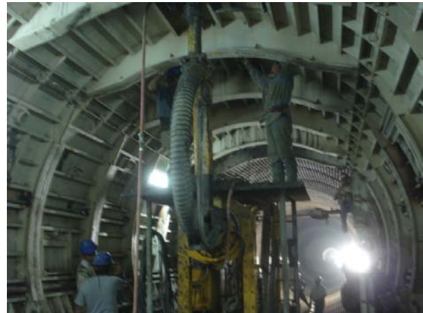
Fig. 2.5.8 Sistema electromecánico de distribución de concreto (Snorkel)
