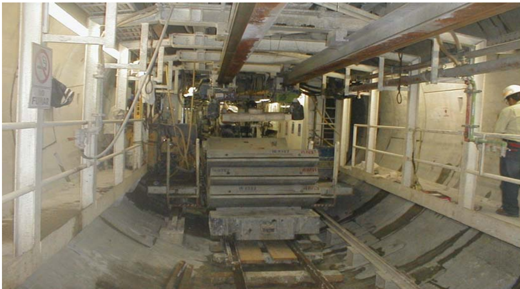
Fig. 4.1.13 Suministro de Dovelas al escudo
