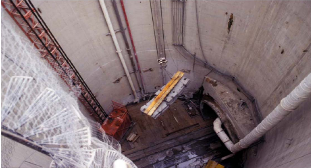
Fig. 2.1.7 Lumbrera de operación y mantenimiento.
