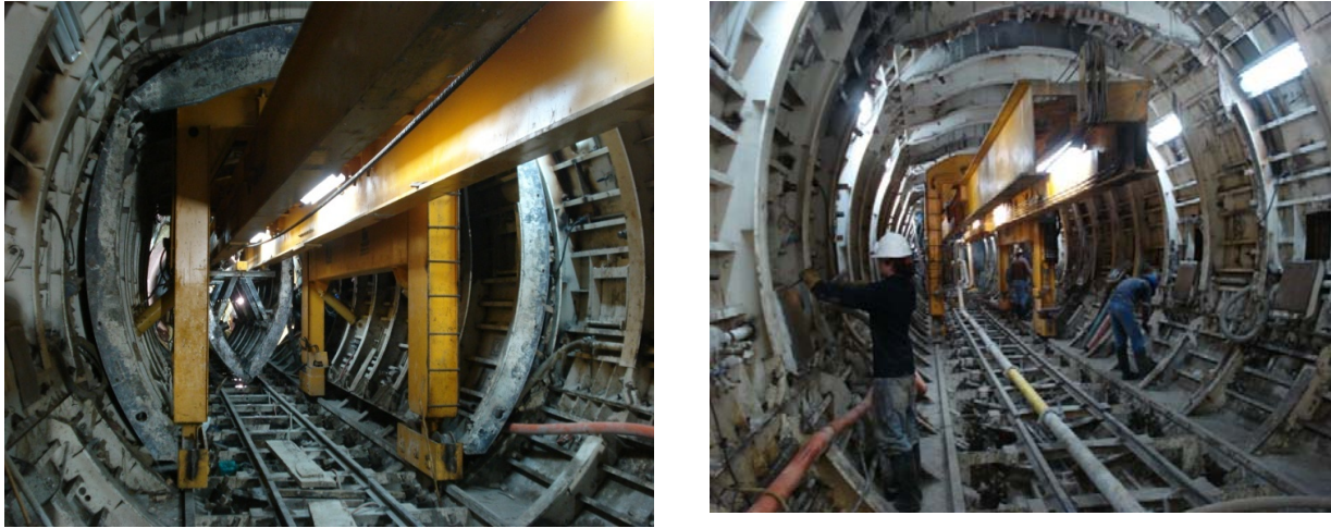
Fig. 2.5.9 Sistema transportador de la cimbra
