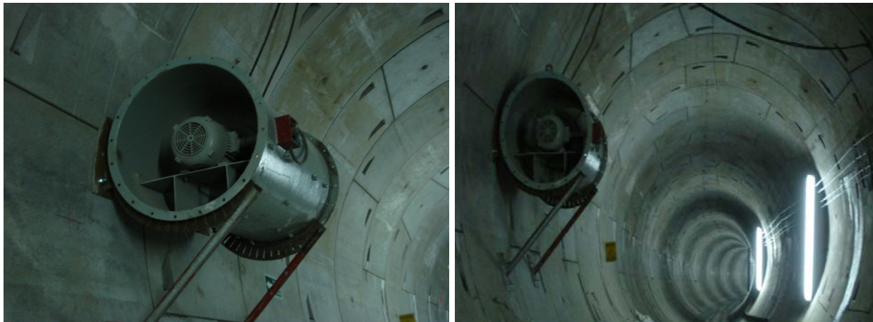
Fig. 2.4.5 Ventilación del túnel
