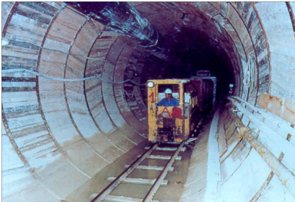
Fig. 2.3.5 Estabilizado de paredes del túnel por medio de anillo metálico y polines.
