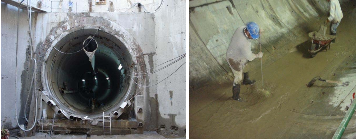
Fig. 4.2.1 Desmantelamiento y limpieza para iniciar los trabajos del revestimiento definitivo.
