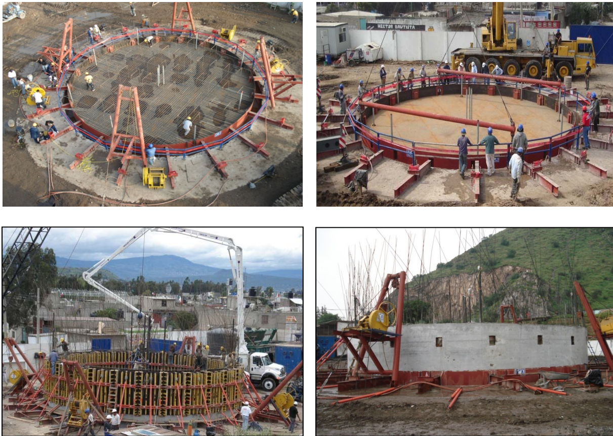
Fig. 2.1.5 Procedimiento constructivo por el método de “flotación”
