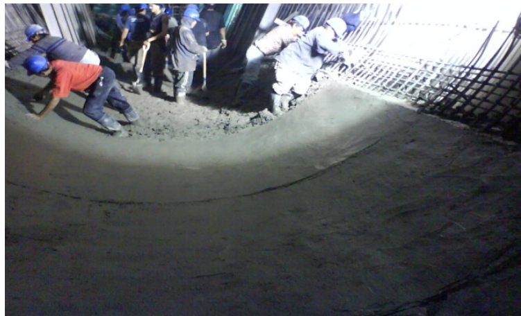
Fig. 4.2.14. Colocación de concreto en zona de cubeta
