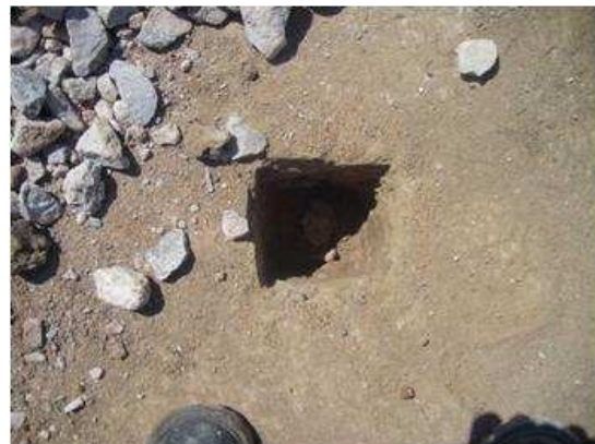
IMAGEN II.7. 2 Vista de cala para prueba de compactación
