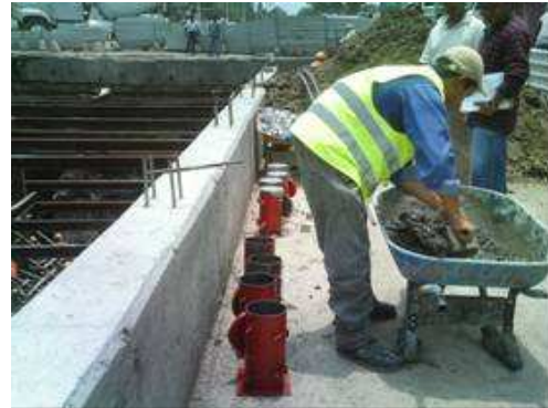
IMAGEN III.4. 2 Se mezcla antes de depositar la primer parte a los moldes
