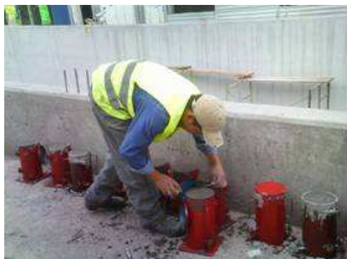
IMAGEN III.4. 7 Enrasado de los moldes
