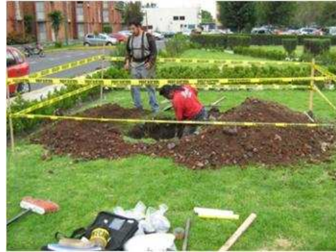
IMAGEN I.3. 2 Excavación del pozo a cielo abierto
