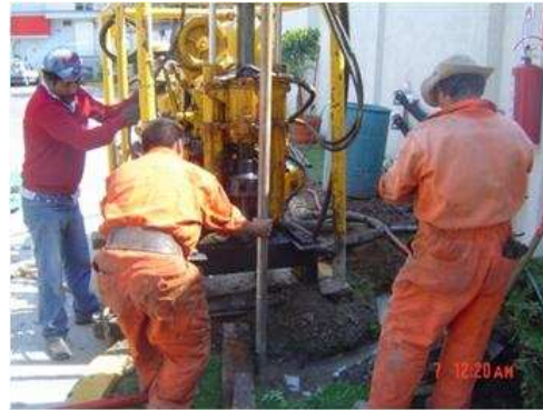
IMAGEN I.4 8 Extracción de la muestra inalterada SPT.
