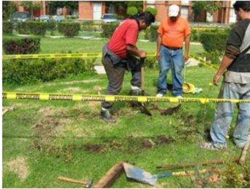
IMAGEN I.3. 1 Inicio de los trabajos del pozo a cielo abierto
