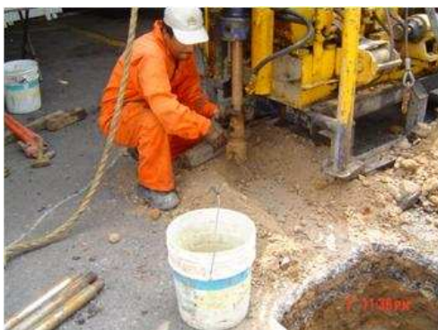
IMAGEN I.4 5 Colocación de la broca para perforación
