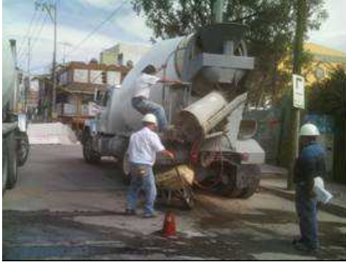
IMAGEN III.3. 1 Equipo previamente humedecido y colocado en sitio para ejecución de la prueba
