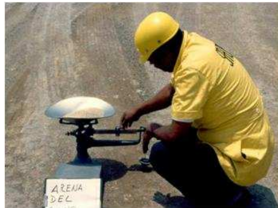
IMAGEN II.7. 6 Peso de arena colocada en la cala.
