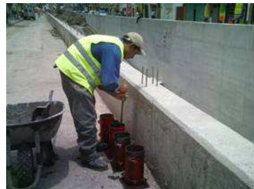
IMAGEN III.4. 4 Compactación mediante 25 penetraciones de la varilla punta de bala.
