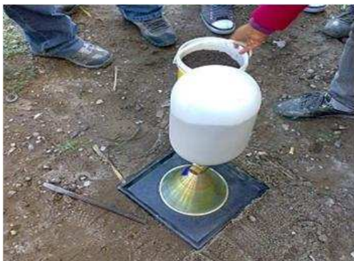
IMAGEN II.8. 5 Colocación de cono en placa base.
