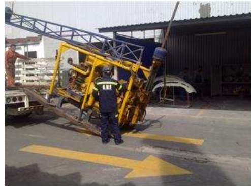
IMAGEN I.4 2 Montaje de la máquina
