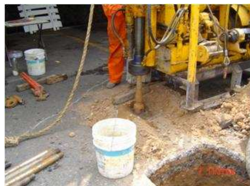
IMAGEN I.4 6 Inicio del trabajo de perforación (SPT)
