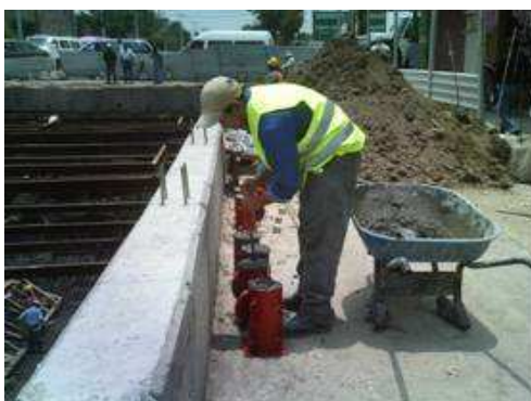
IMAGEN III.4. 5 Colocación de la tercer capa del molde y su compactación.
