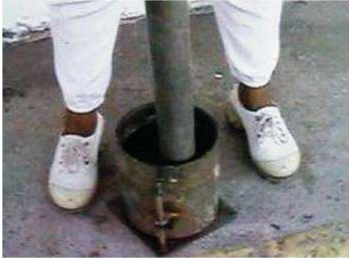
IMAGEN II.9. 7 Compactación del material
