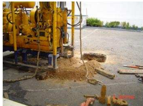
IMAGEN I.4 4 Vista de la colocación del equipo de perforación
