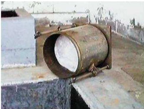
IMAGEN II.9. 15 Vista de escurrimiento de agua superficial del molde.
