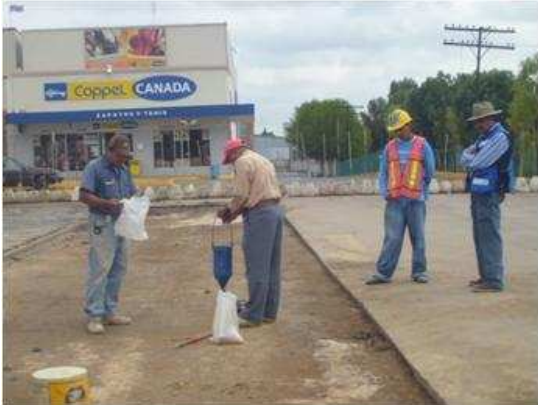
IMAGEN II.7. 3 Colocación de arena en cala
