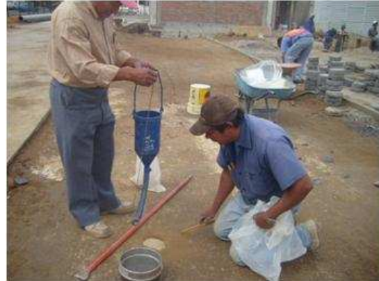
IMAGEN II.7. 4 Colocación de arena en cala
