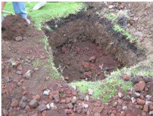
IMAGEN I.3. 3 Vista de las paredes del pozo a cielo abierto
