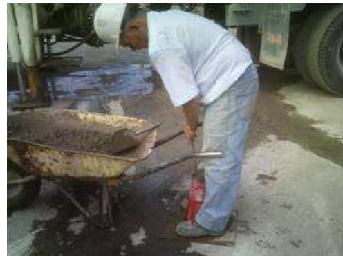
IMAGEN III.3. 4 Compactación mediante 25 penetraciones de la varilla punta de bala.
