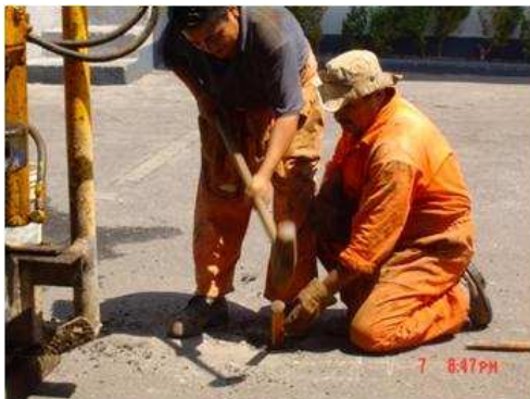
IMAGEN I.4 3 Excavación de cala para fluidos de perforación
