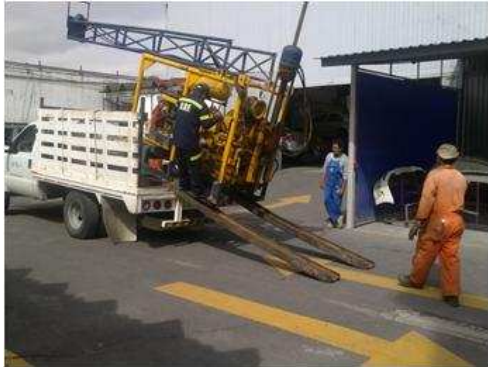
IMAGEN I.4 1 Colocación de la máquina perforadora en el sitio
