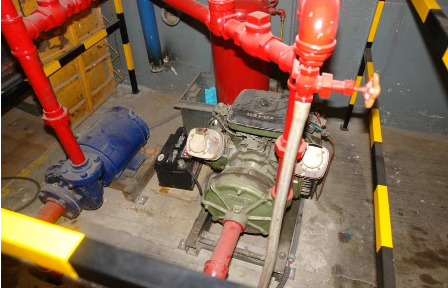
Figura 4.13. Bomba eléctrica (izquierda) y bomba de combustión interna (derecha)
