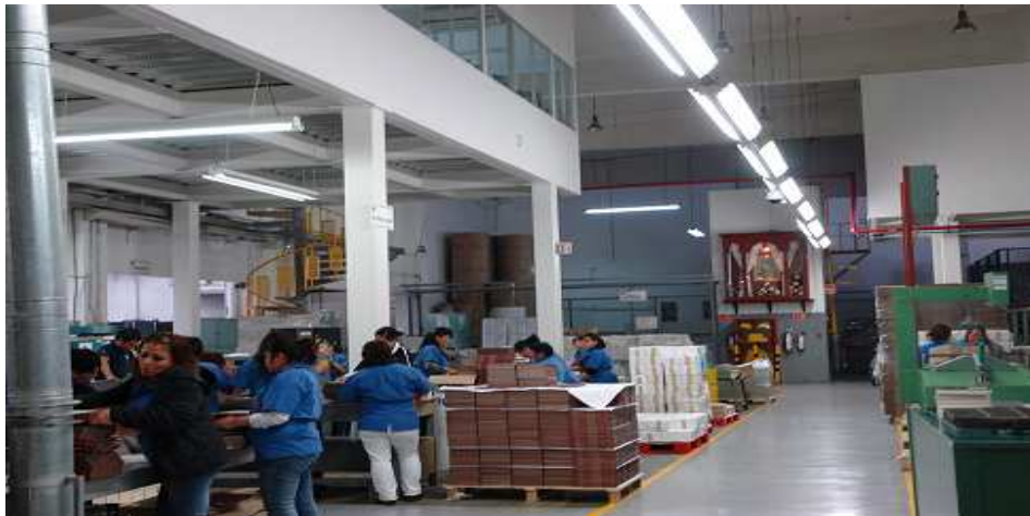
Figura 4.42. Luminarias en pasillos.
