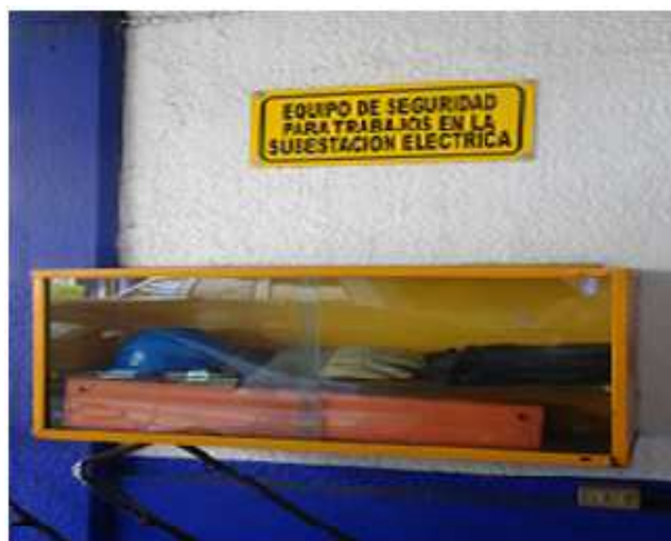
Figura 4.48. Equipo de protección personal subestación
