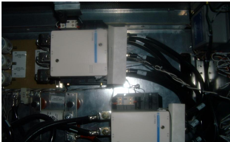
Fig. 3.9 Interruptores de Bypass estático
