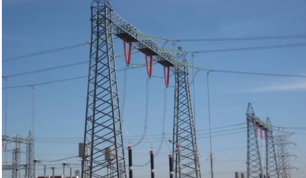
Figura 1.2.1.1 marcos de subestación
