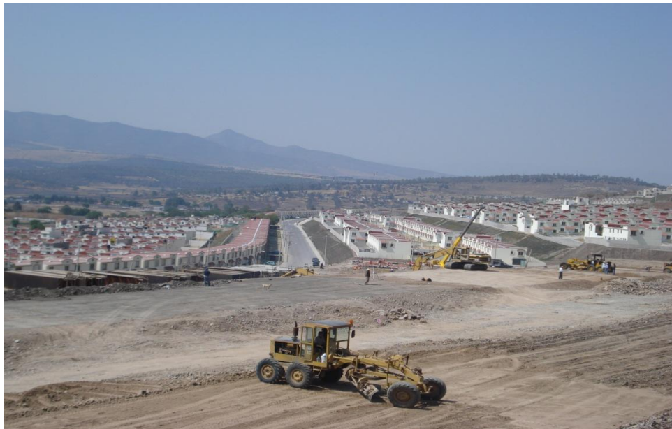
Obras de infraestructura de la unidad
