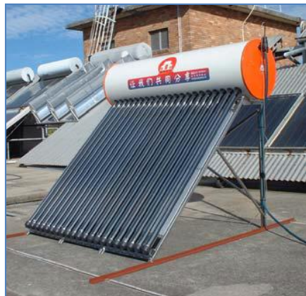
FIGURA 2. 1.- Sistema de colección solar de tubos a vacío (Fuente: Budihardjo, 2005. Evacuated Tubular Solar Water Heaters).
