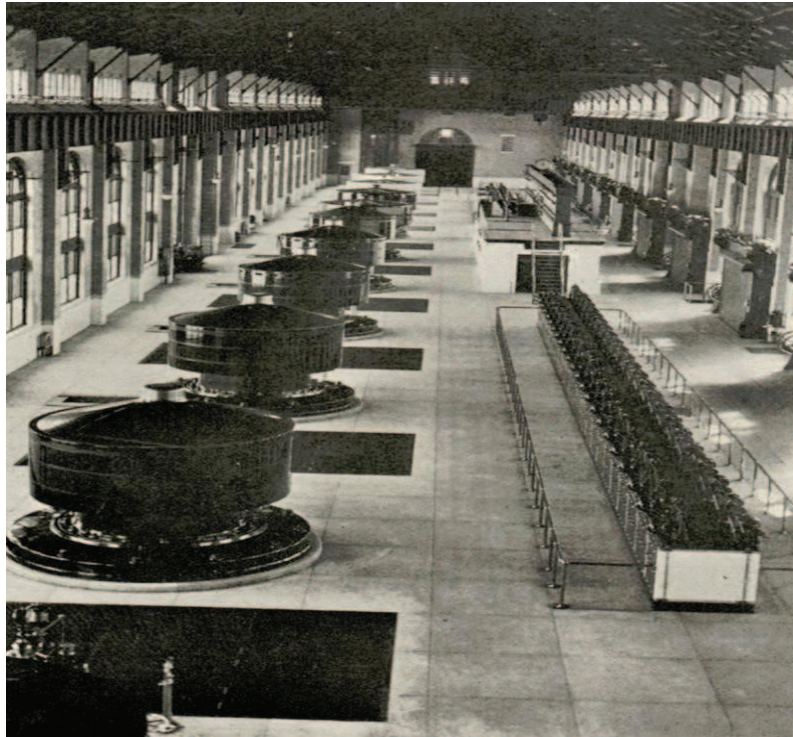
Figura 1.9. Interior de la planta generadora Niagara Falls Power.
