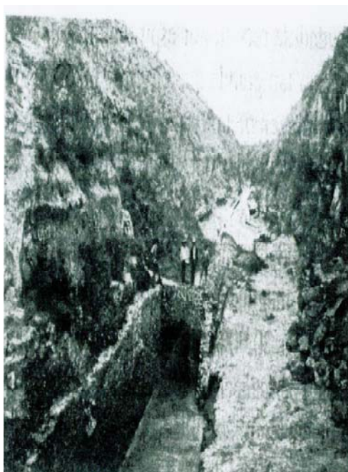
Imagen 5. Bóveda Real, último fragmento del túnel (Perló, 1999: 45).
