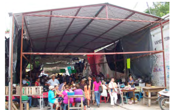
Se ha techado la calle para guarecer a los tianguistas del sol y de la lluvia.
