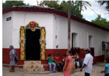
Fachada típica restaurada.
