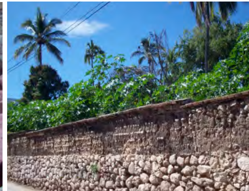
Basamento de piedra y muro de adobe
