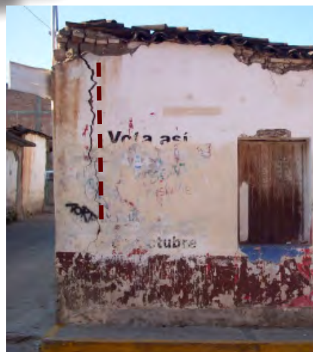
Fachada norte de edificación típica
