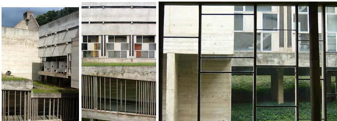
FIGURA 45. En estas imágenes se aprecia parte de las terrazas de los dormitorios que dan al patio interior del edificio, y una vista del interior del edificio hacia el patio.
