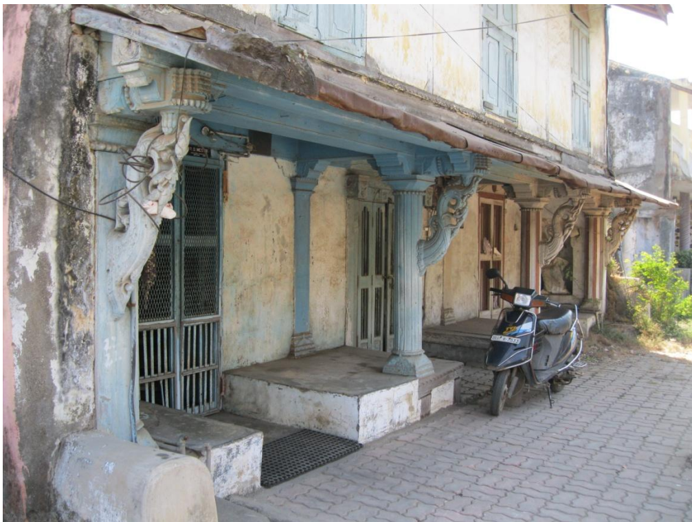
22 6 . Pórtico de una casa particular en Daman. Daman y Diu, India. Foto: Esteban García Brosseau.
