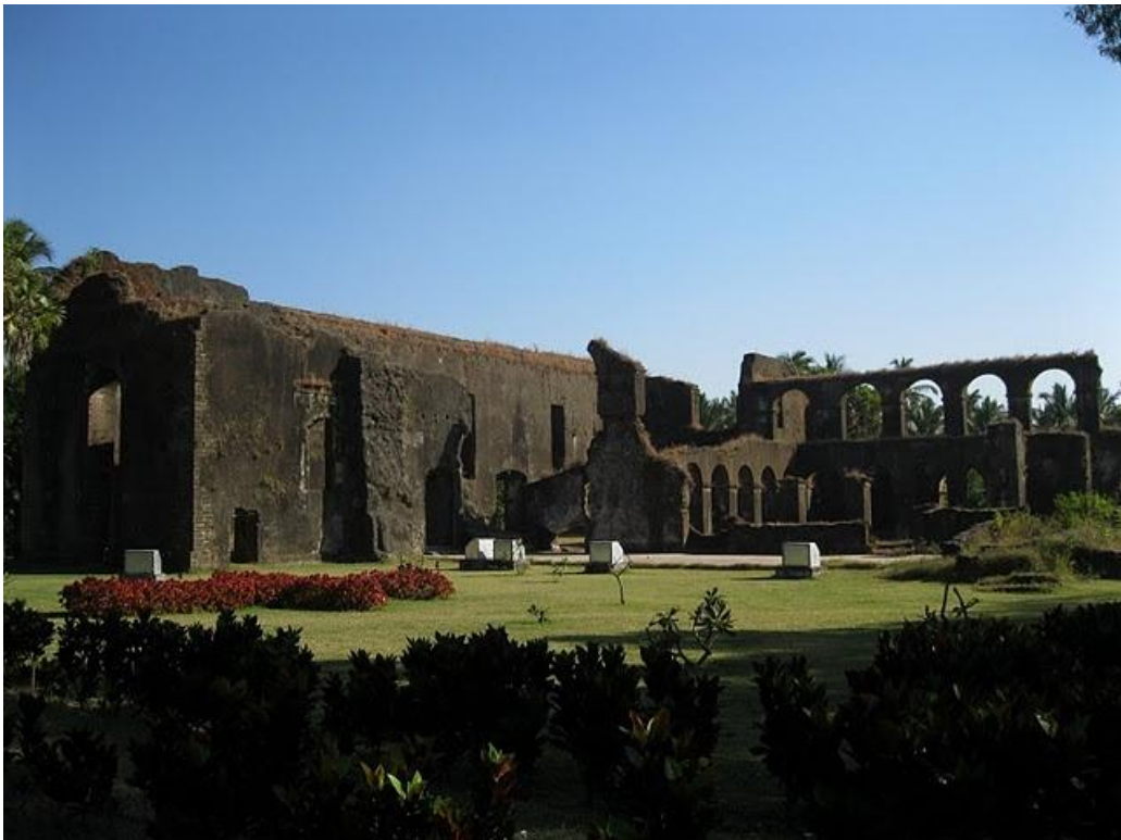
3. Ruinas del convento dominico en la zona oeste del fuerte de Daman. Foto: Esteban García Brosseau.
