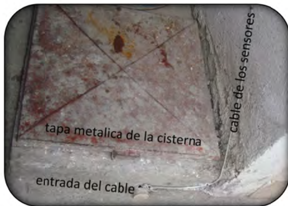
Ilustración 23: Tapa metálica de la cisterna de concreto.
