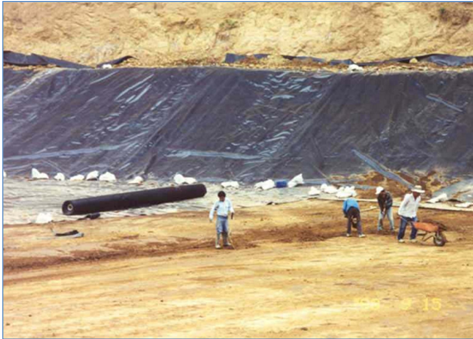
Figura 1.11 Preparación de un sitio de disposición (SEGEM, 2003)
