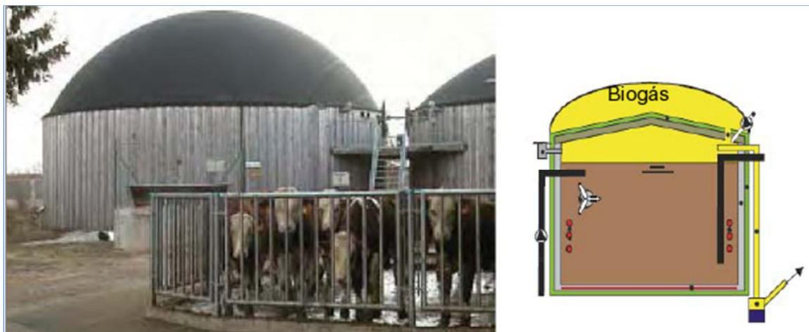
Figura 2.5 Digestor completamente mezclado (Ostrem, 2004)
