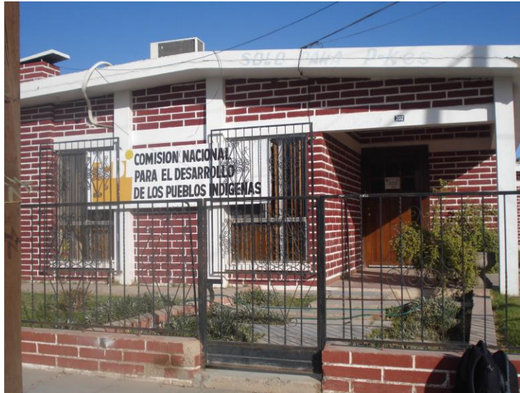
Figura 15. Instalaciones del centro coordinador CDI Caborca. Tomado en 2010 por AMV.
