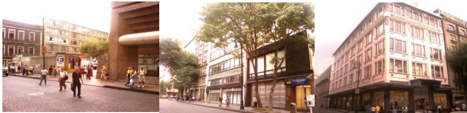
Equipamiento en la calle de 16 de Septiembre entre I. La Católica y Palma.
