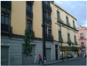
Equipamiento en la calle de República del Salvador.
