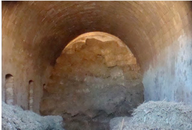
Cubierta de bóveda de ladrillo en las caballerizas de la hacienda
