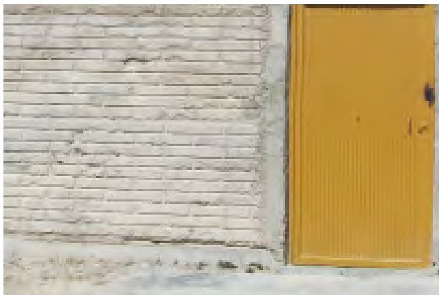
Muro de concreto imitando el adobe
