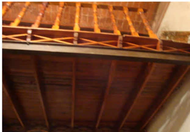
Tapanco de madera con estructura de acero
