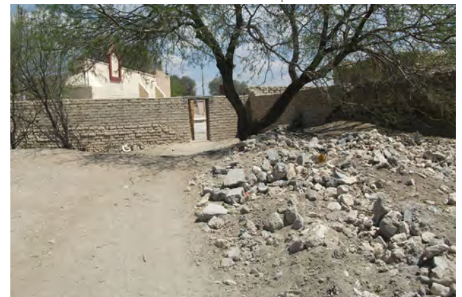
Vista 5. Escombros de adobe dentro del predio.
