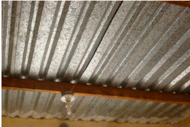
Techo de lámina, se ponen piedras encima para estabilizarlo
