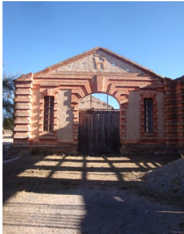
Arco de medio punto en puerta, y ventanas con arco rebajado
