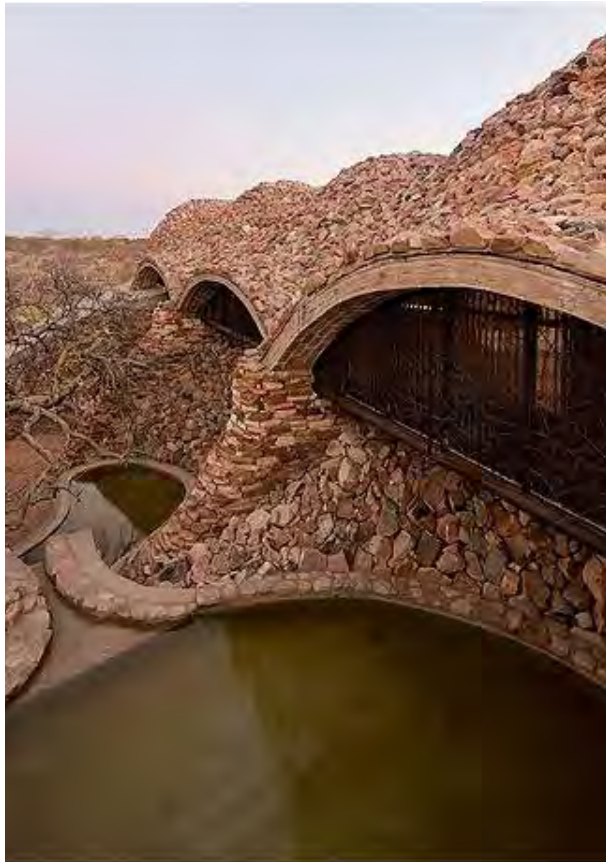
Piletas de agua
