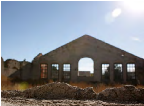
Acceso hacia la bodega principal, antes con cubierta
