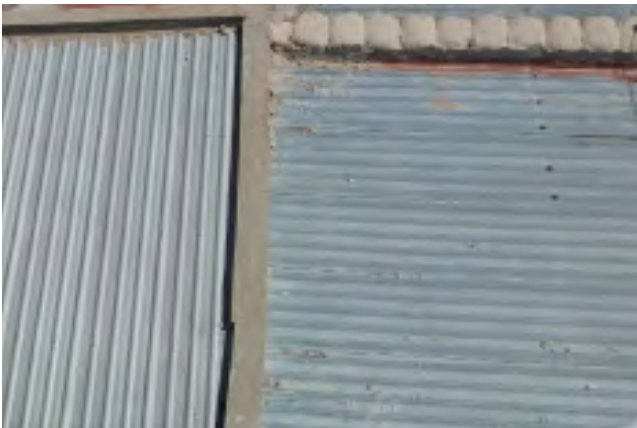
Techo de lámina con muros de concreto y de adobe
