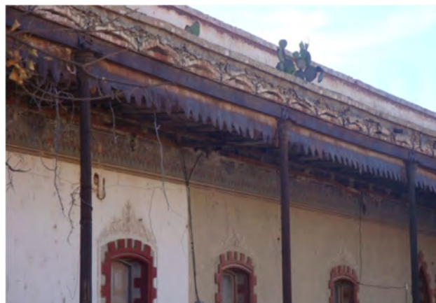
Columnas de hierro, y arcos escazanos en puertas
