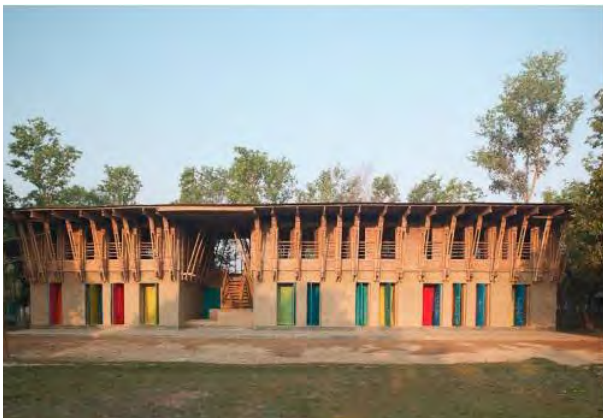
Fachada de Acceso
