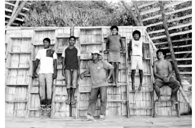
Etapa final de construcción
