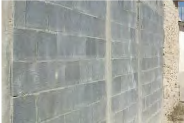
Muro de block de concreto junto a muro de piedra
