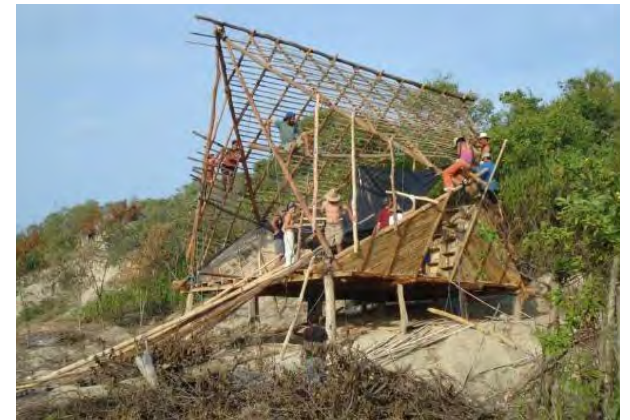
Construcción de la estructura
