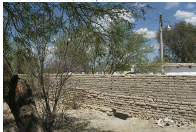
Vista 4. Barda existente con paso de agua pluvial
