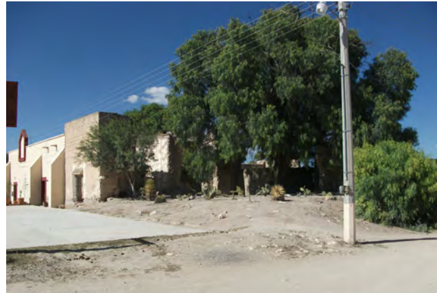
Vista 2. Esquina del predio
