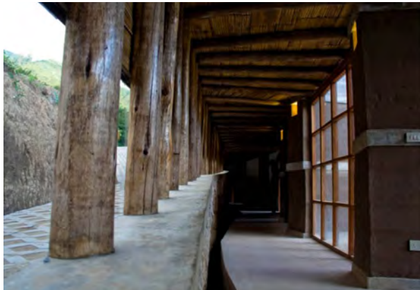
Pasillo abierto-cubierto de acceso a las recámaras
