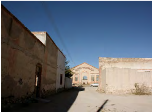
Interior de la Exhacienda ya en ruinas
