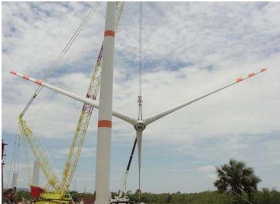
Figura 3.40 Montaje de rotor y aspas de aerogeneradores.
