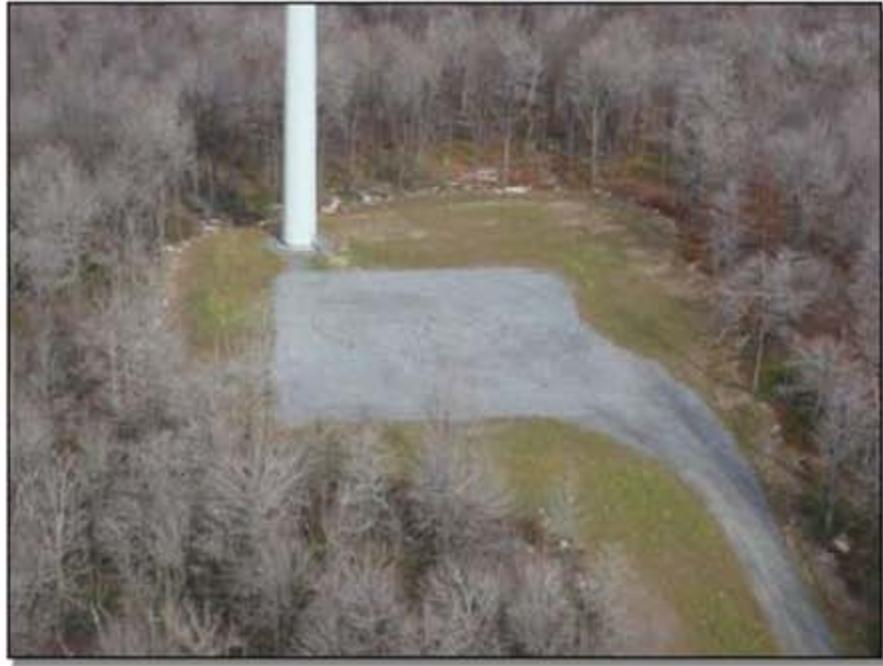
Figura 3.24 Plataforma de montaje para aerogeneradores.
