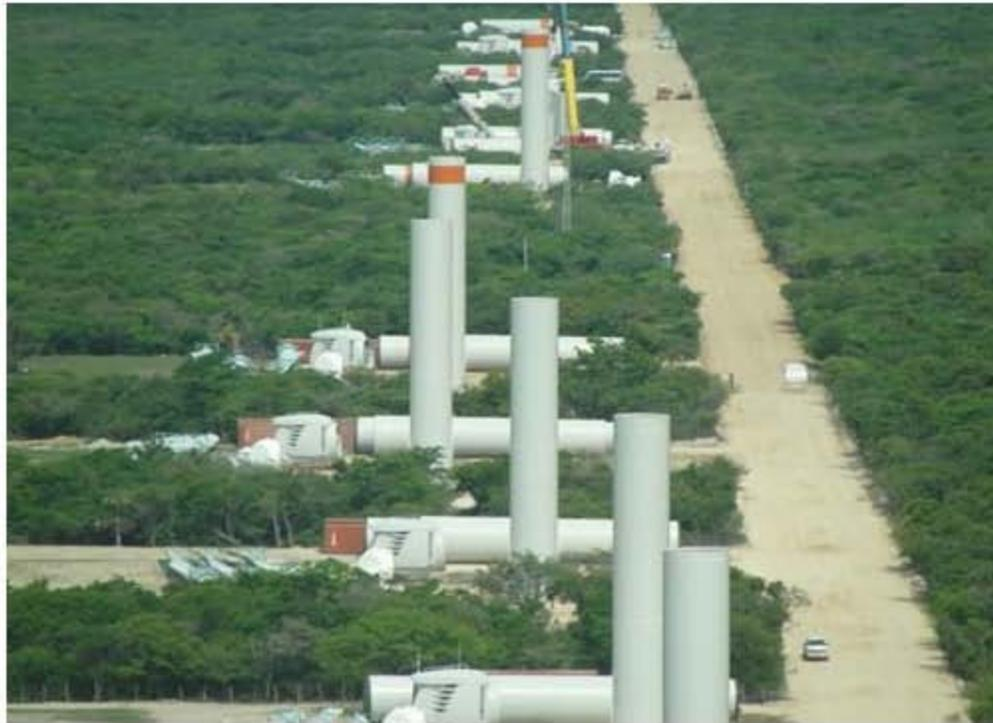
Figura 3.35 Montaje de secciones de torre de aerogeneradores.
