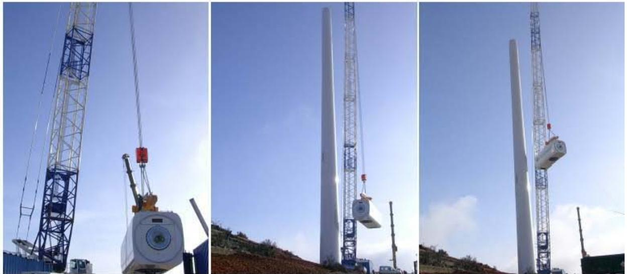
Figura 3.37 Montaje de Nacelle o Góndola.
