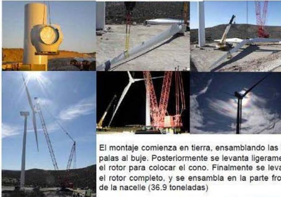
El montaje comienza en tierra, ensamblando las tres palas al buje. Posteriormente se levanta ligeramente el rotor para colocar el cono. Finalmente se levanta el rotor completo, y se ensambla en la parte frontal de la nacelle (36.9 toneladas)
