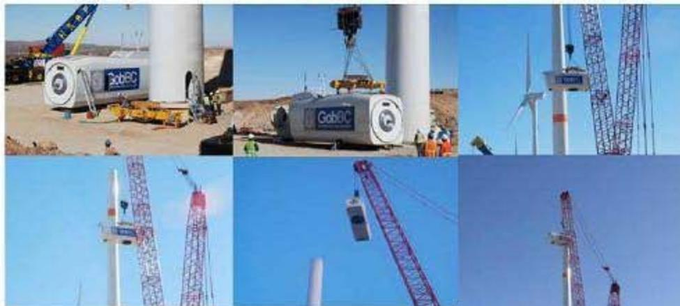
Una vez montada la torre se procede a la instalación de la nacelle, la cual se acopla al último tramo de la torre y se procede a la conexión eléctrica de todos los componentes (70 toneladas)
