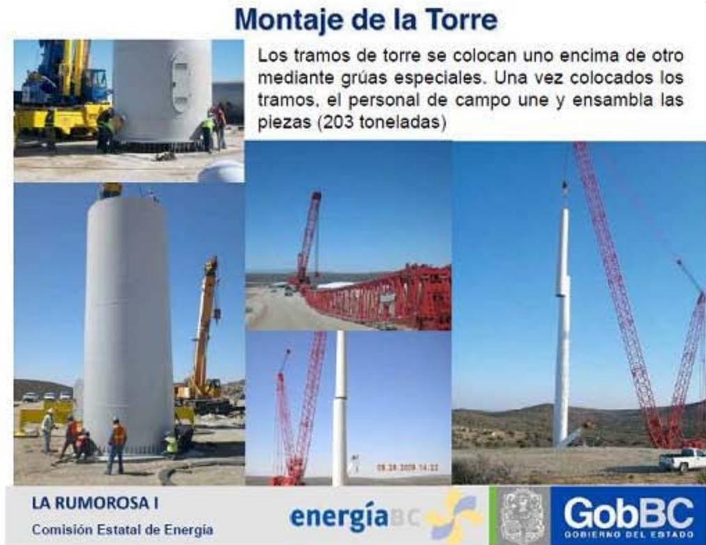
Figura 3.34 Montaje de un parque eólico con aerogeneradores de 2 MW.
