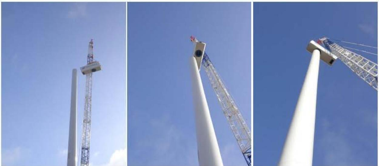
Figura 3.38 Montaje de Nacelle o Góndola.
