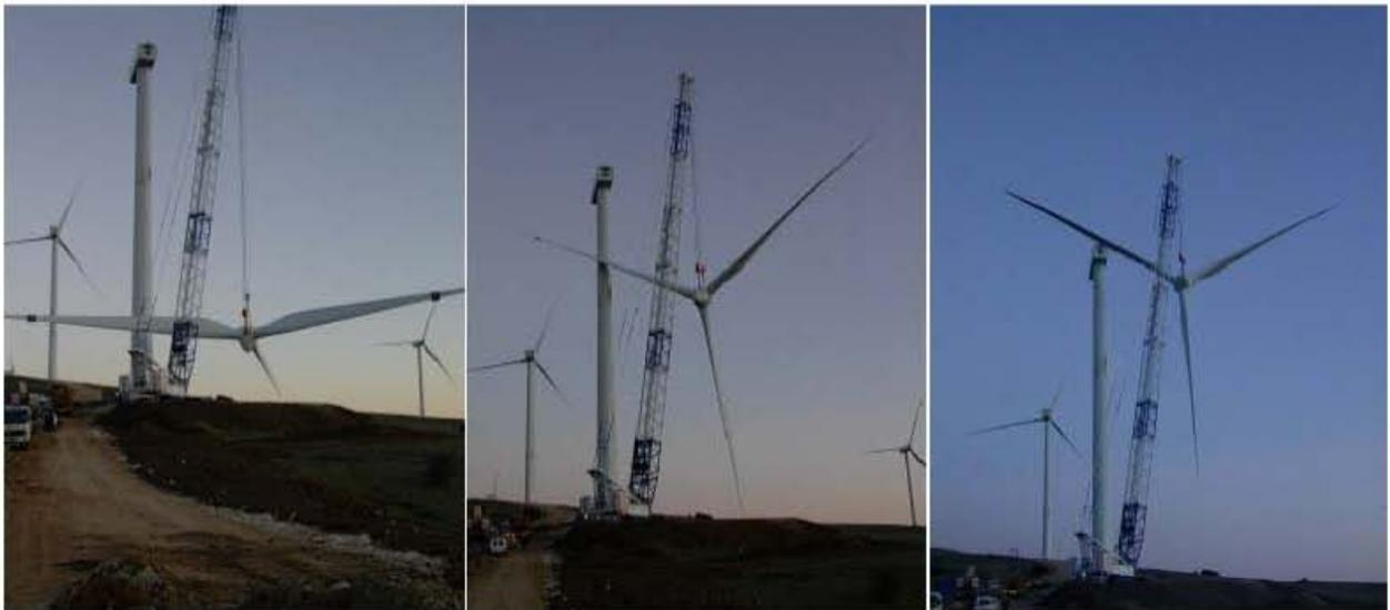
Figura 3.42 Montaje de rotor y aspas de aerogeneradores.
