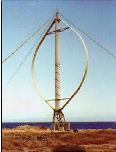
Figura 1.23. Aerogenerador de eje Vertical.
