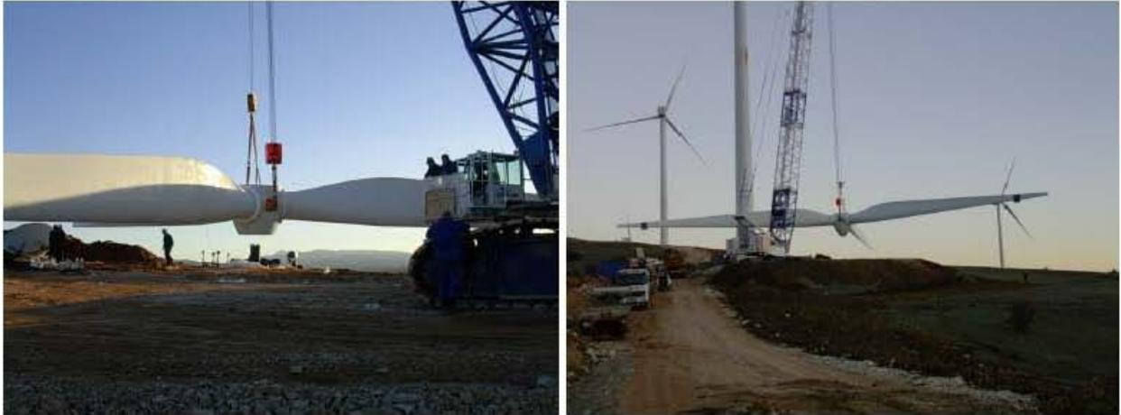
Figura 3.41 Montaje de rotor y aspas de aerogeneradores.
