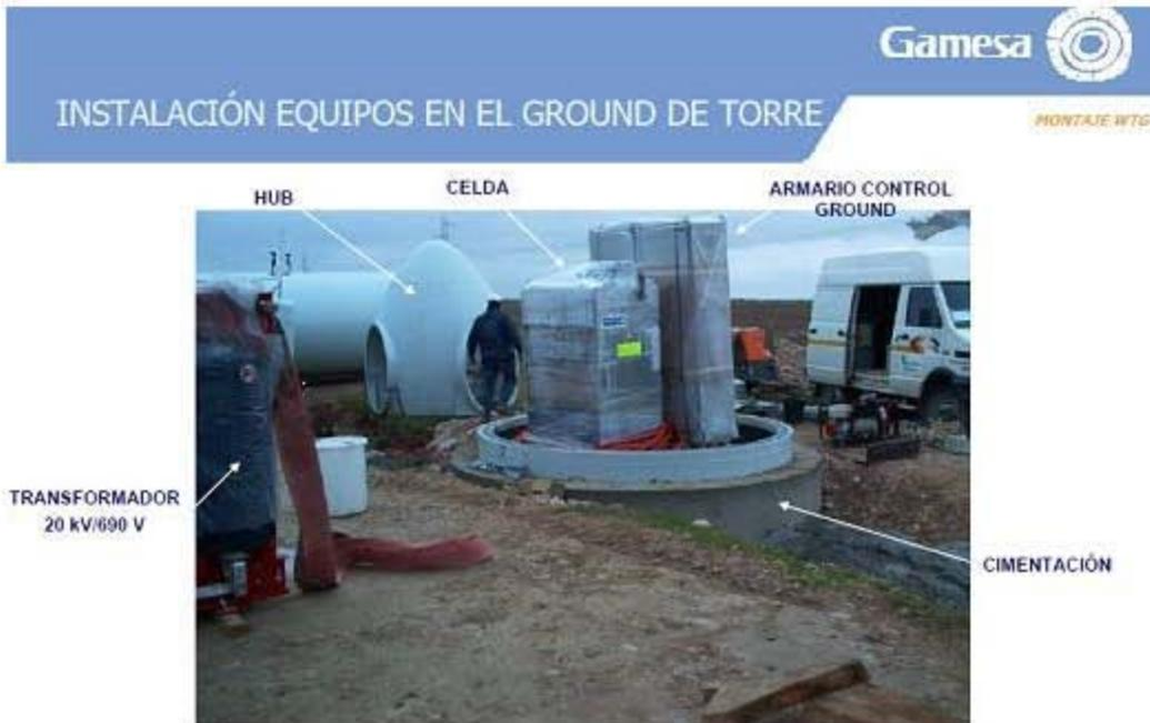
Figura 3.33 Ejemplo de montaje de equipos en plataforma de la torre.
