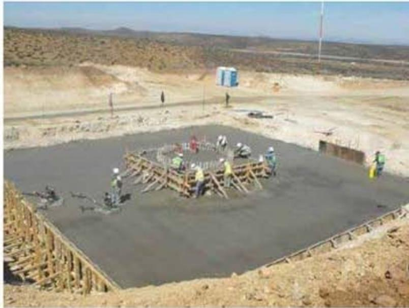
Figura 3.28 Cimentación de un parque eólico con aerogeneradores de 2 MW.
