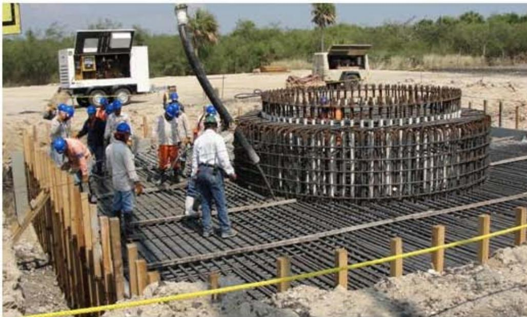
Figura 3.29 Armado y hormigonado de cimentación para aerogenerador
