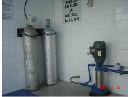
Ilustración 6.2 Sistema de cloración por medio de gas
